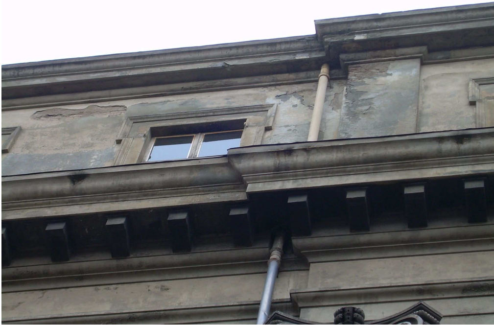
Particolare gronde e pluviali
