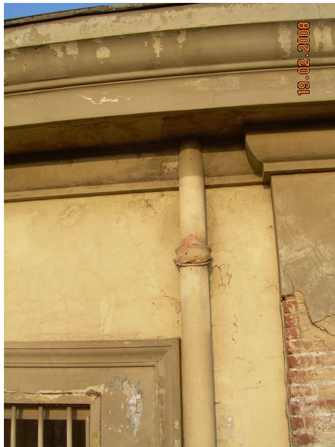
Particolare gronda e pluviale
