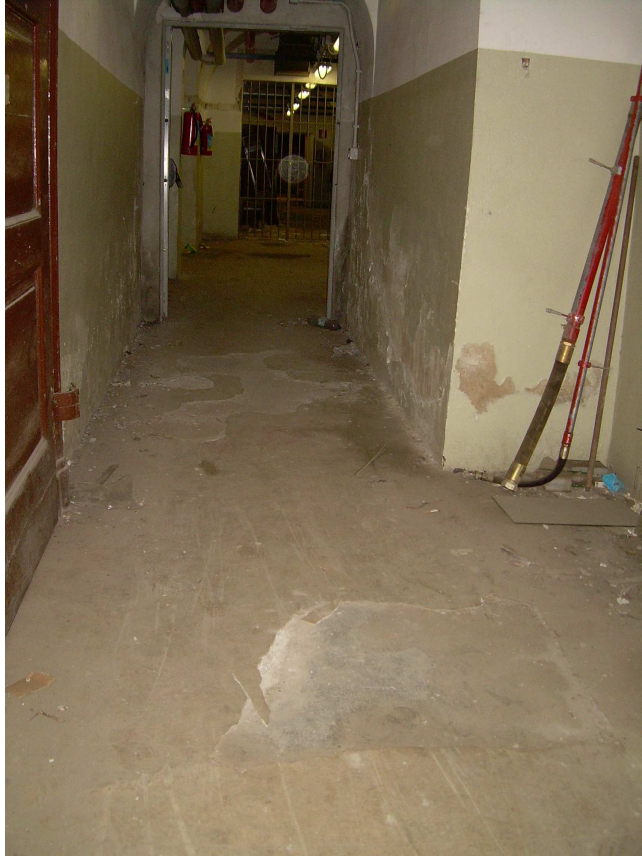
Piano interrato – Manica via S. Agostino – pavimento
