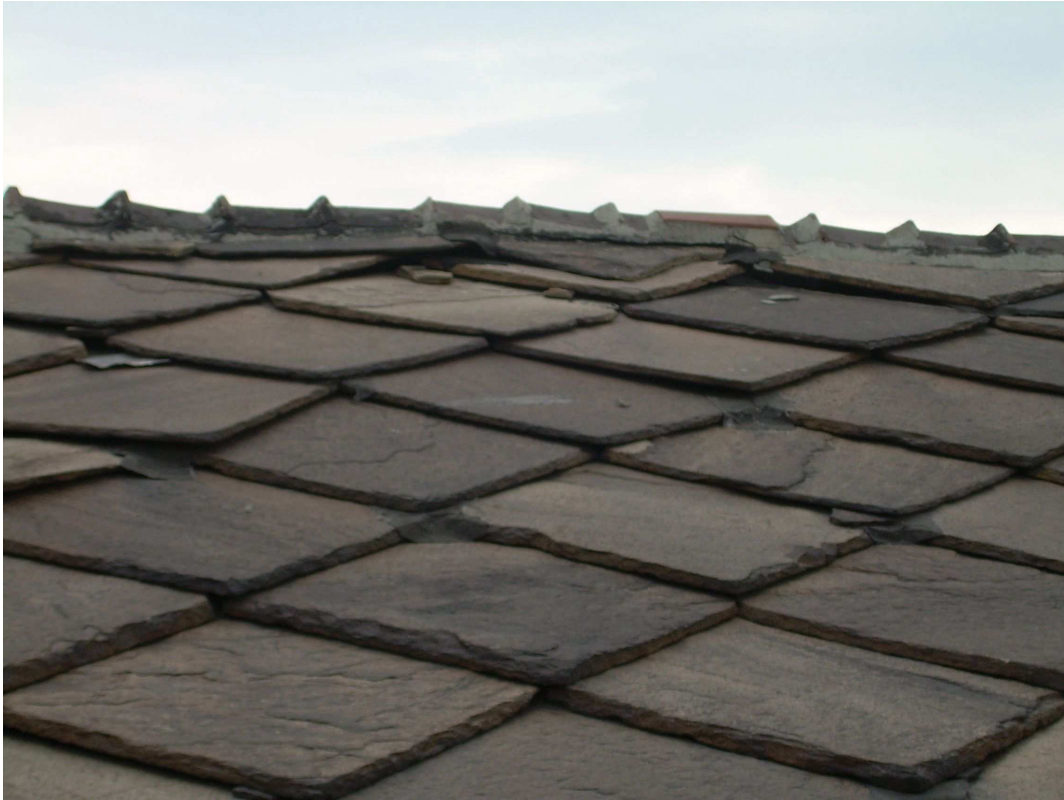
Particolare copertura – lose in pietra di Luserna
