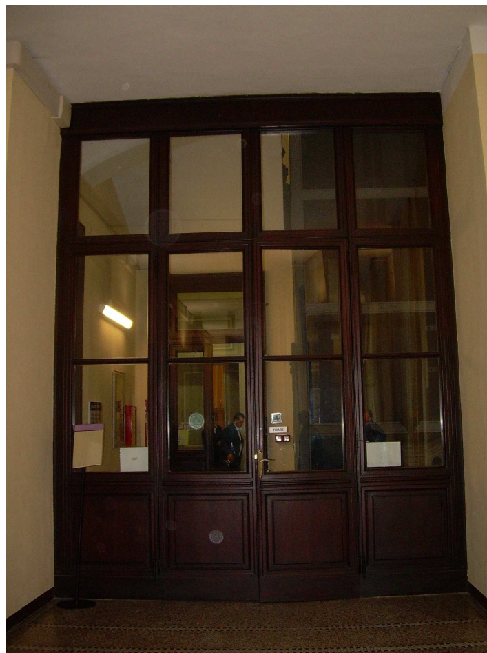
Piano terreno – manica su via San Domenico _parete vetrata da spostare e conservare
