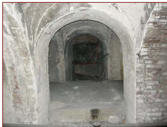
sopra la soletta del rifugio anticrollo
