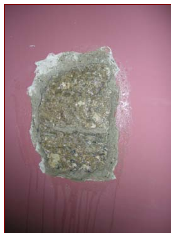
Saggio sul pilastro dove emergono i conci di pietra
