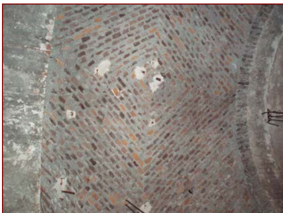
p. interrato: particolare di una volta
