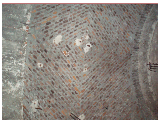
p. interrato: particolare di una volta
