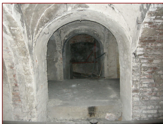
sopra la soletta del rifugio anticrollo
