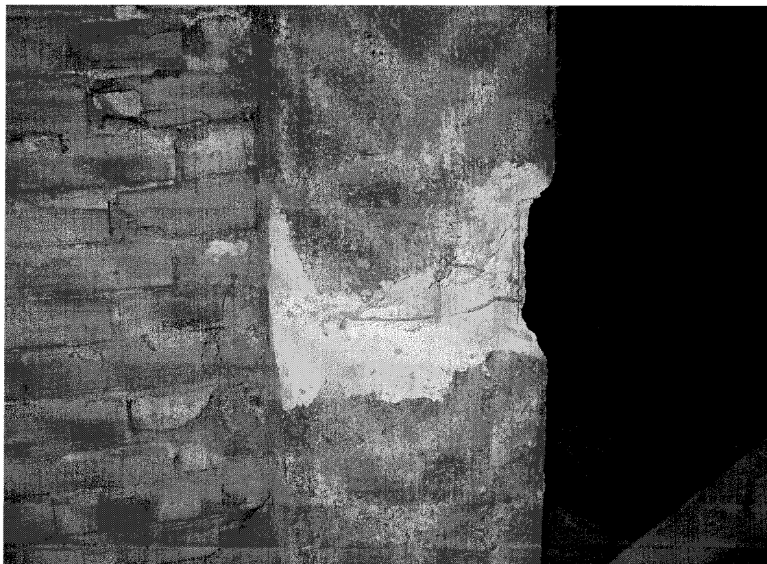
Fig. 10: Armatura pilastri da piano Quarto a tetto
