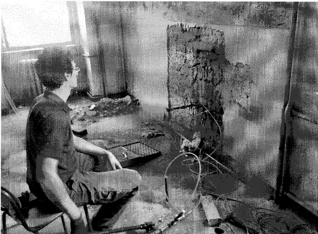
Fig. 11: Prova a martinetto doppio su muratura 2° piano su Via San Domenico
