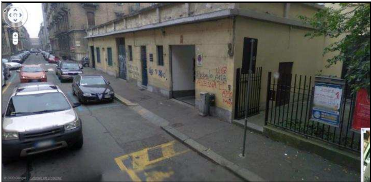
ingresso carraio su via Perrone
