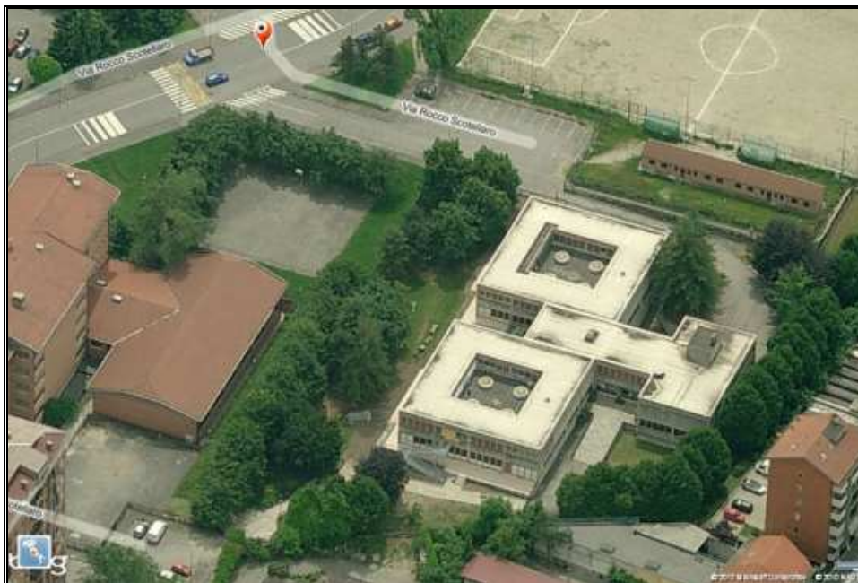
vista area cortile
