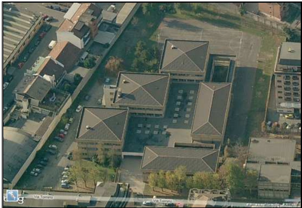
vista area cortile
