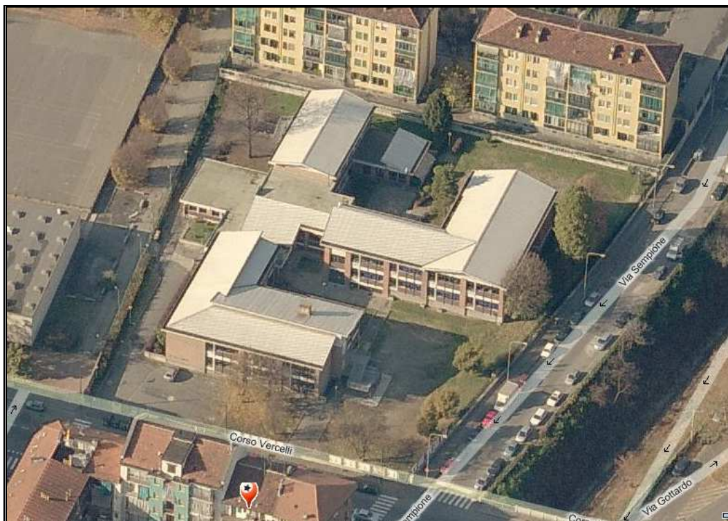
vista area cortile
