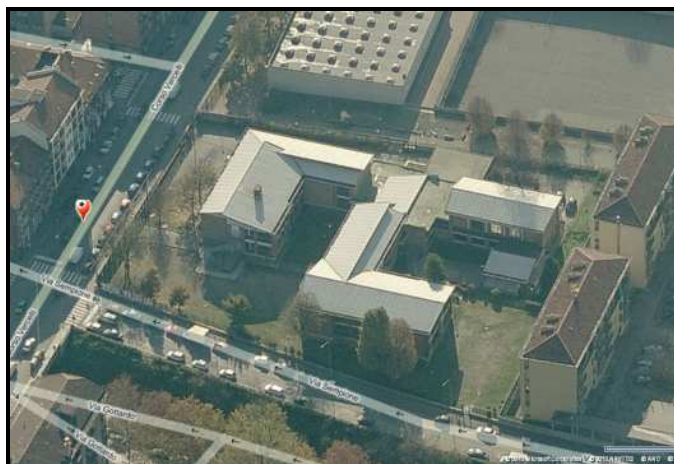
vista area cortile
