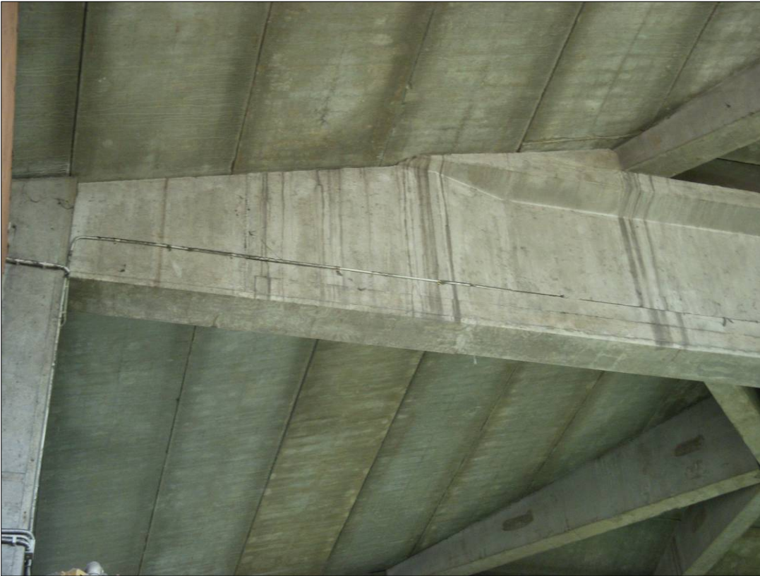
Figura 7 - Dettaglio della capriata di copertura della palestra
