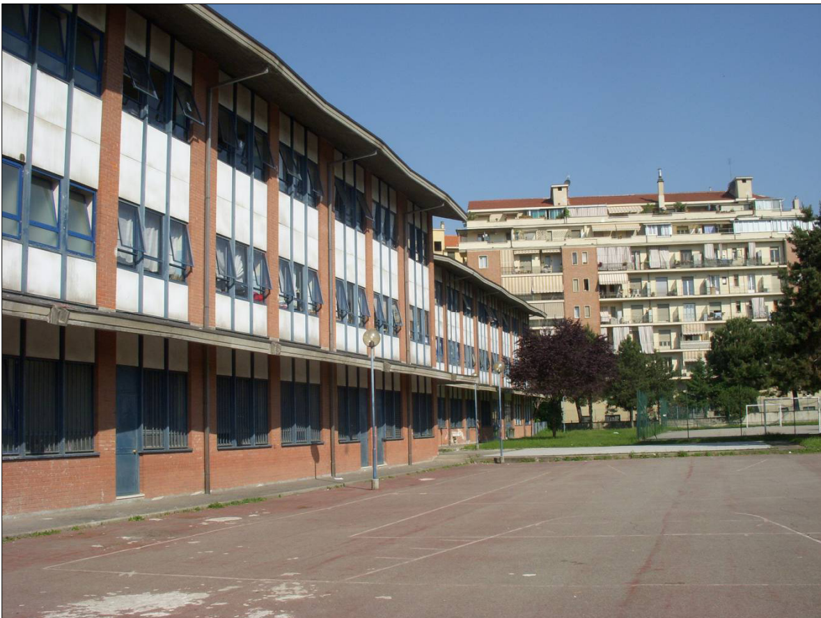
Figura 2 - Vista dei fabbricati dal lato cortile
