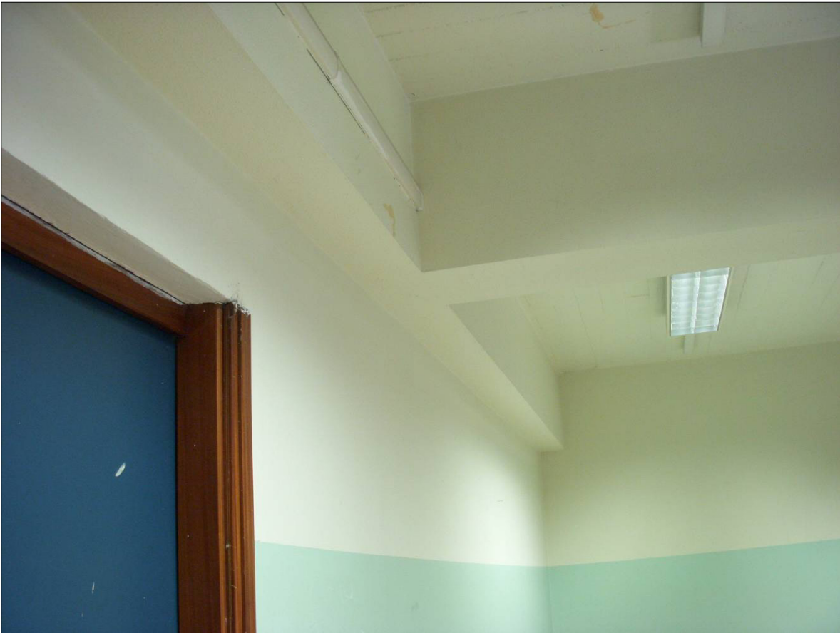
Figura 3 - Vista di dettaglio delle travi ribassate
