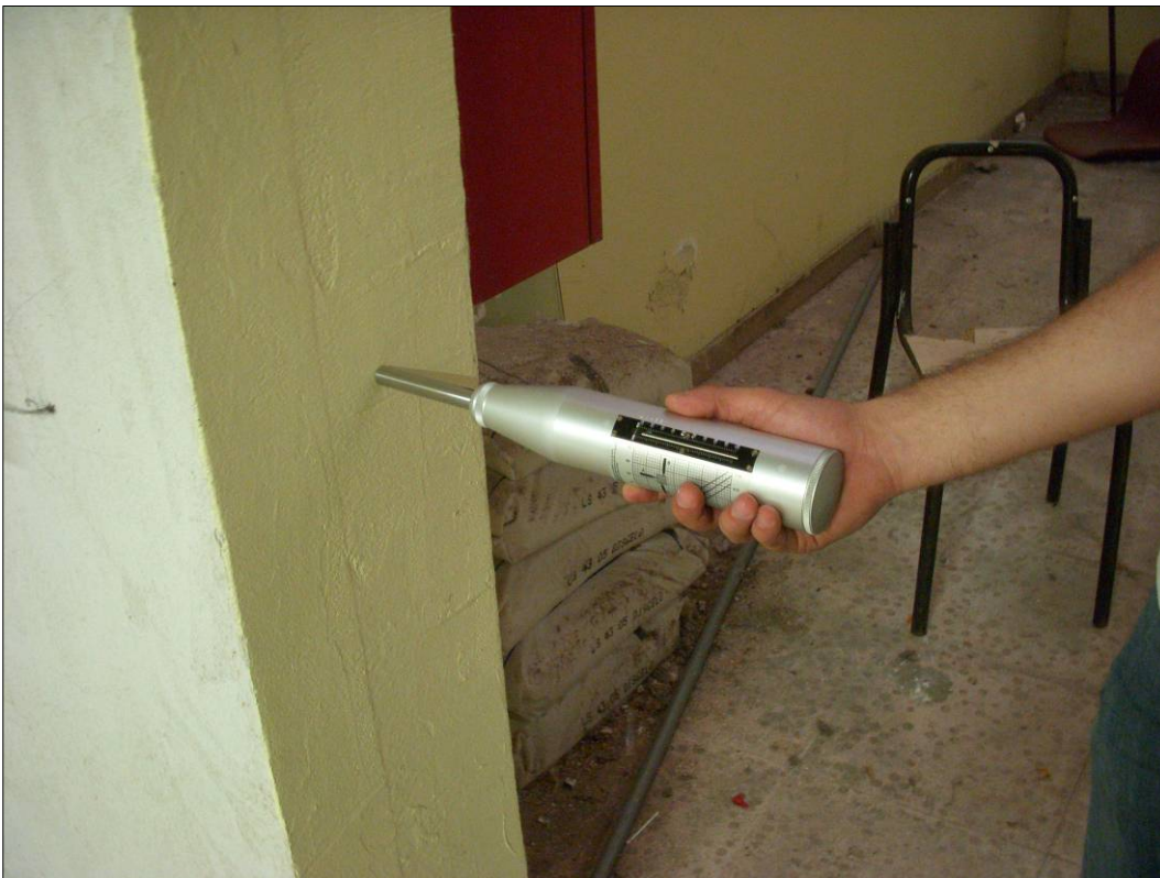
Figura 18 - Esecuzione di una battuta con sclerometro
