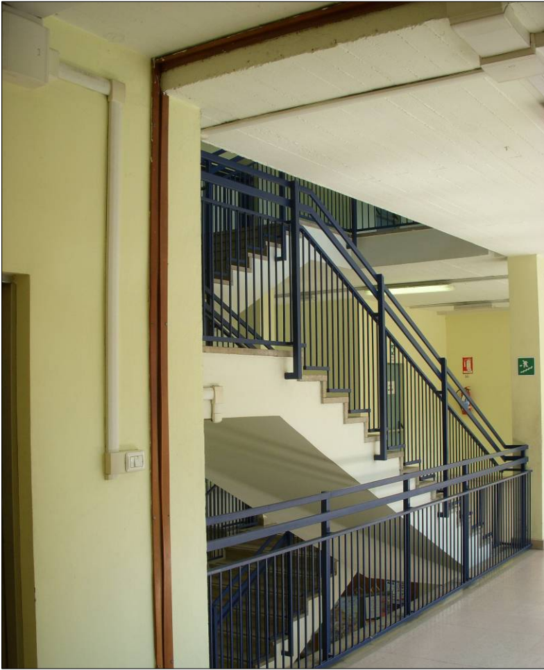
Figura 13 - Vista del corpo scale e del giunto di separazione
