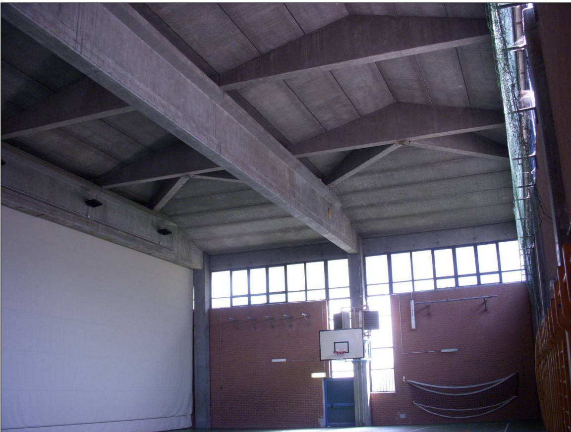
Figura 6 - Vista della struttura di copertura della palestra
