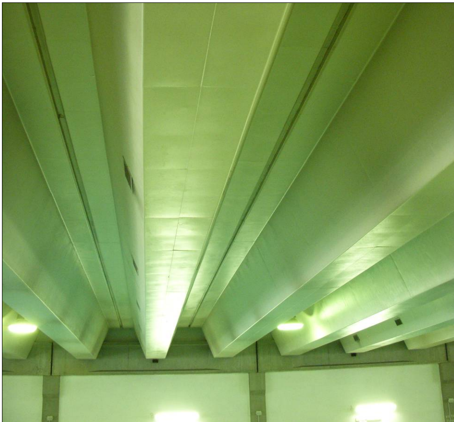
Figura 8 - Vista delle travi a cassone dalla piscina
