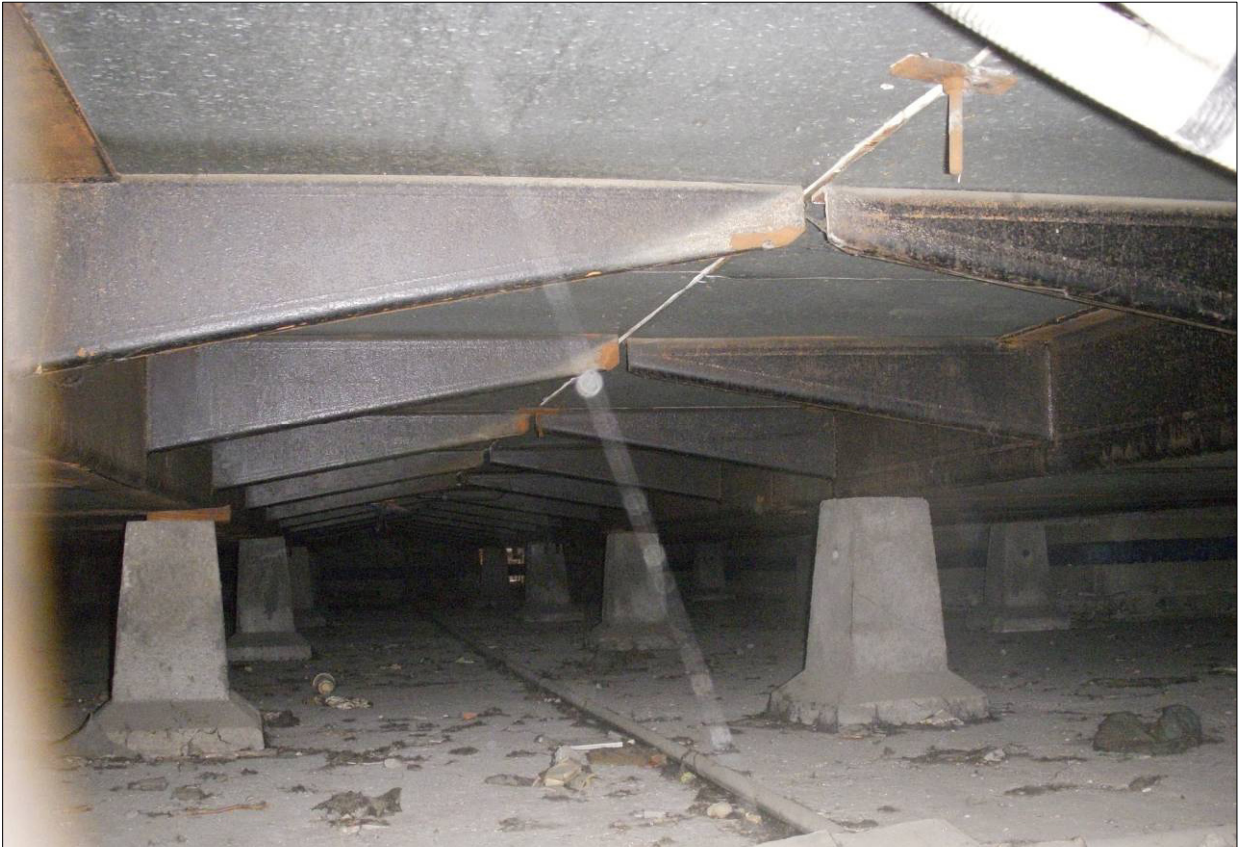
Figura 7 - Vista delle fondazioni sopraelevate
