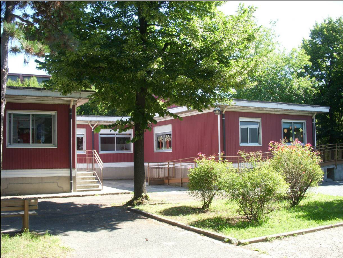
Figura 1 - Vista dei moduli prefabbricati dal lato cortile (sud)
