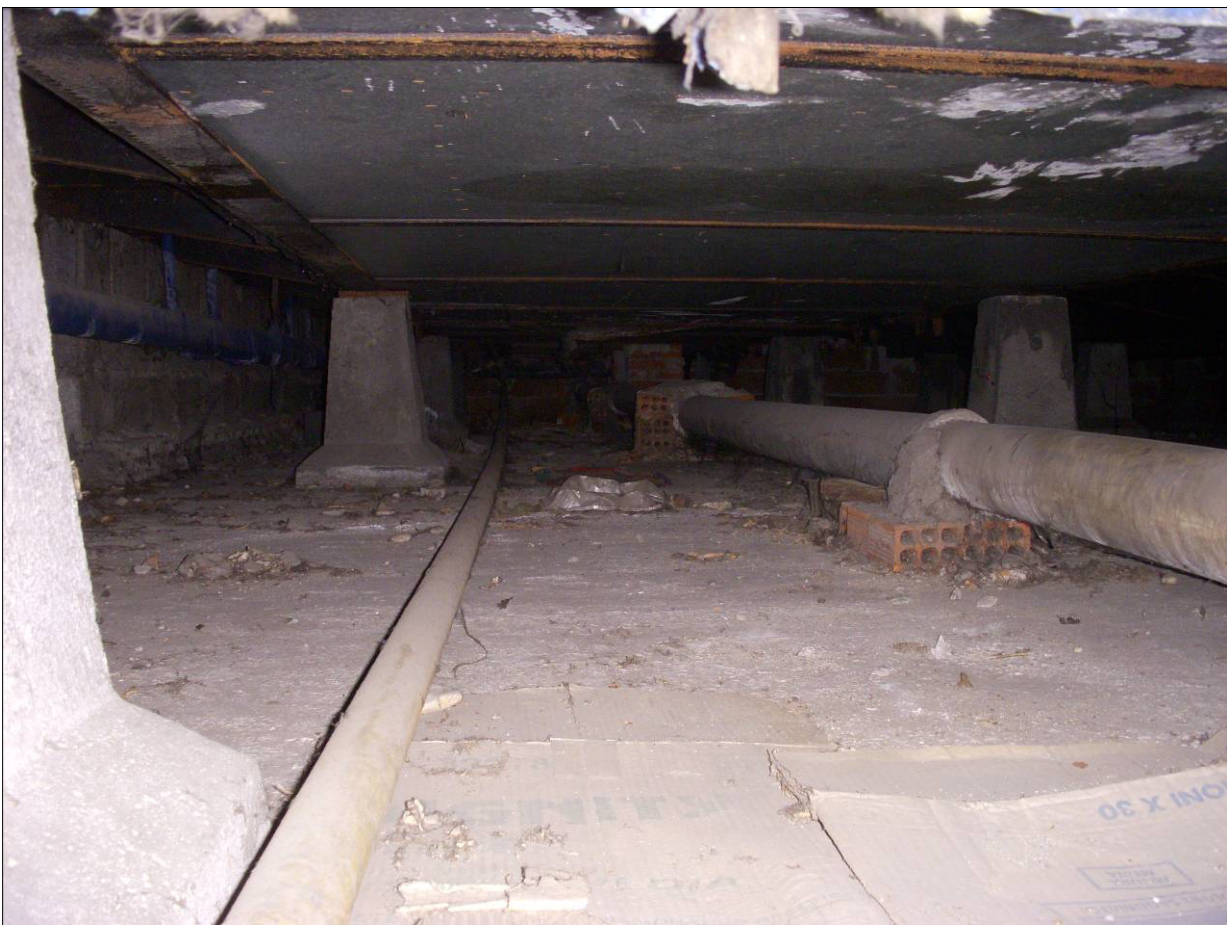
Figura 8 - Vista delle fondazioni sopraelevate
