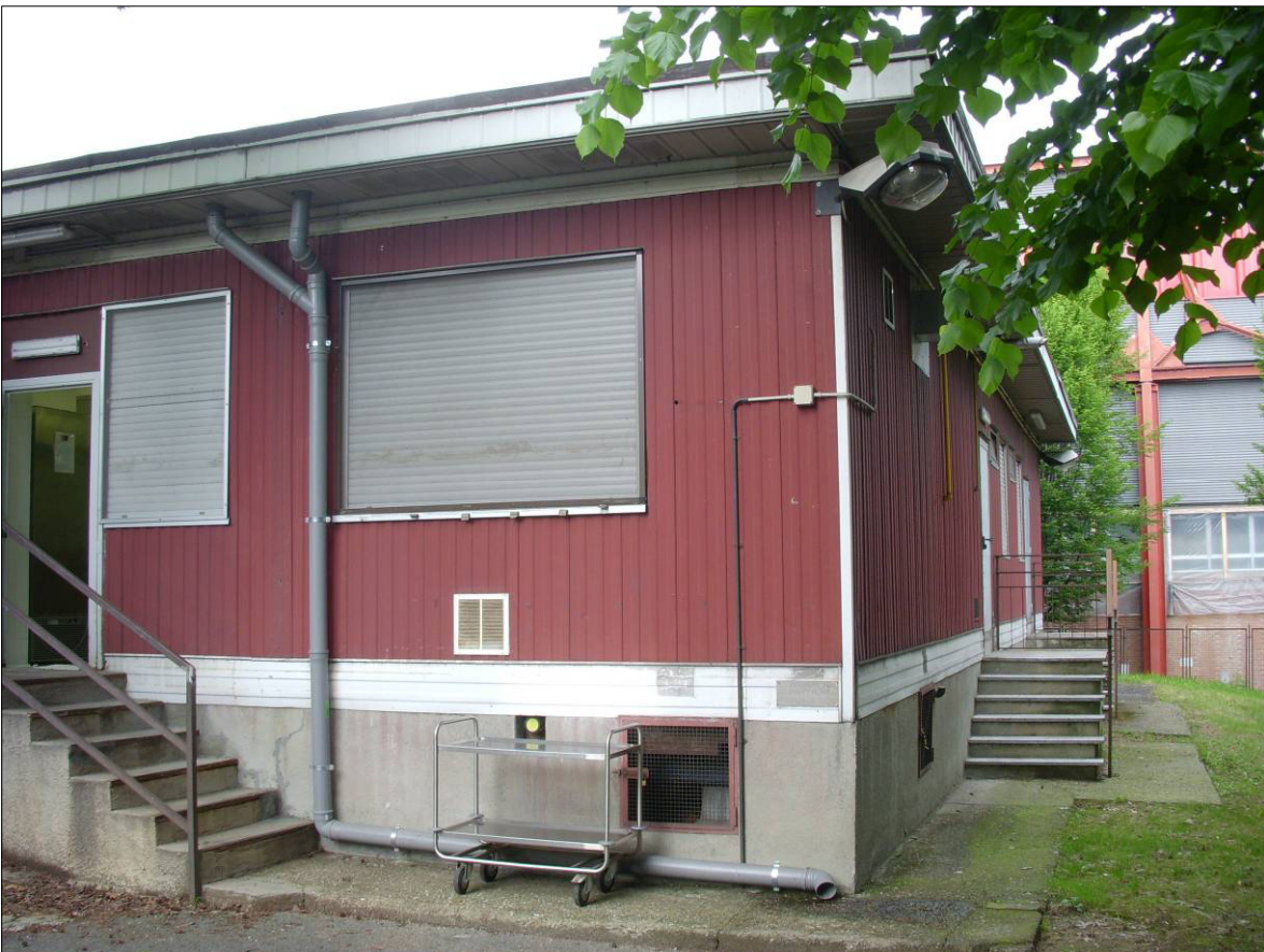
Figura 2 - Vista di un modulo in corrispondenza della cucina
