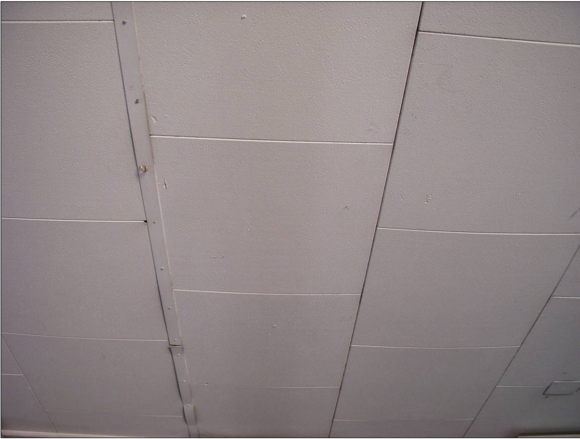
Figura 3 - Dettaglio del controsoffitto ad orditura nascosta
