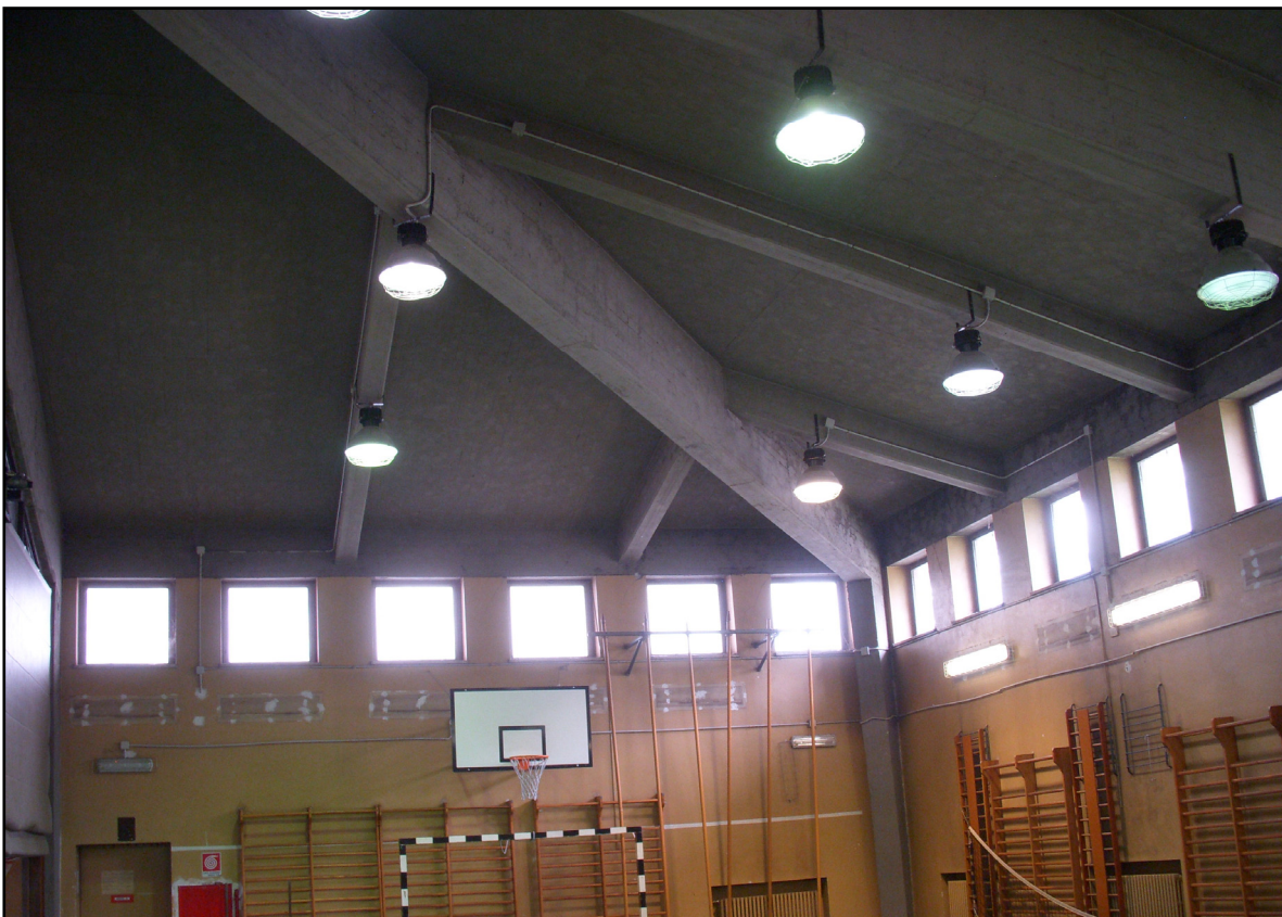
Figura 8 - Struttura di copertura della palestra
