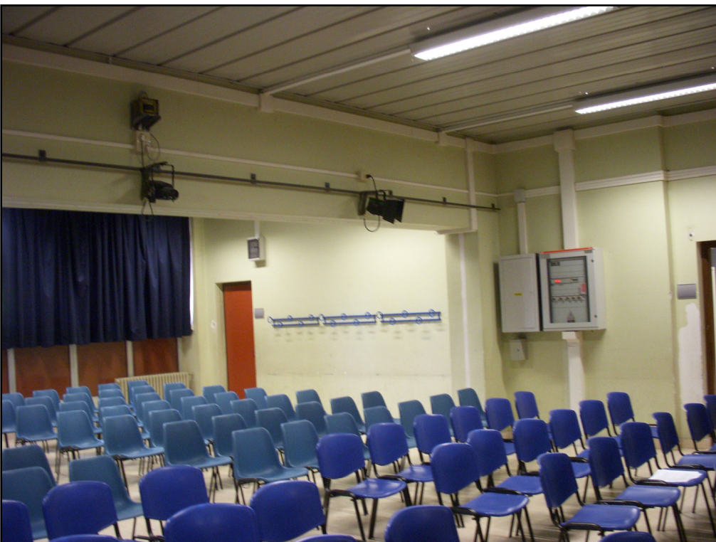
Figura 6 - Travi ribassate al piano interrato del corpo 2
