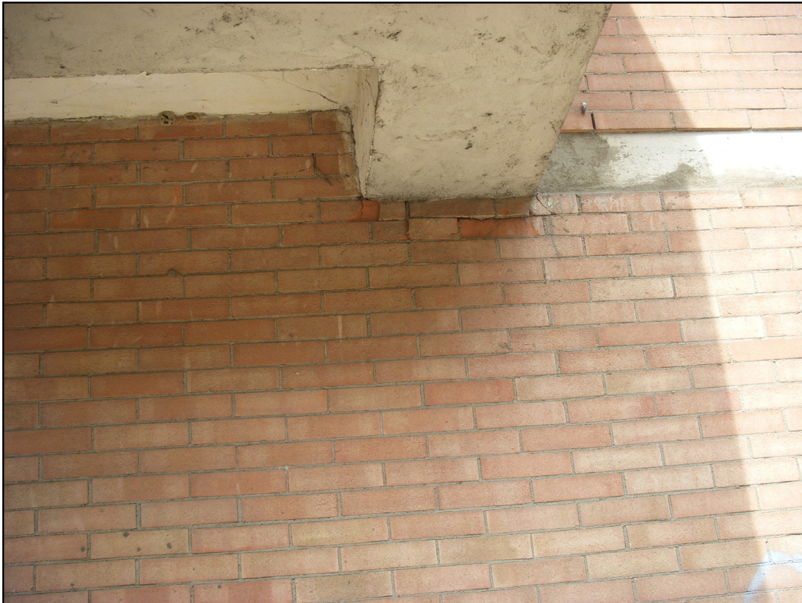
Figura 12 - Schiacciamento dei mattoni sotto trave ribassata corpo 1
