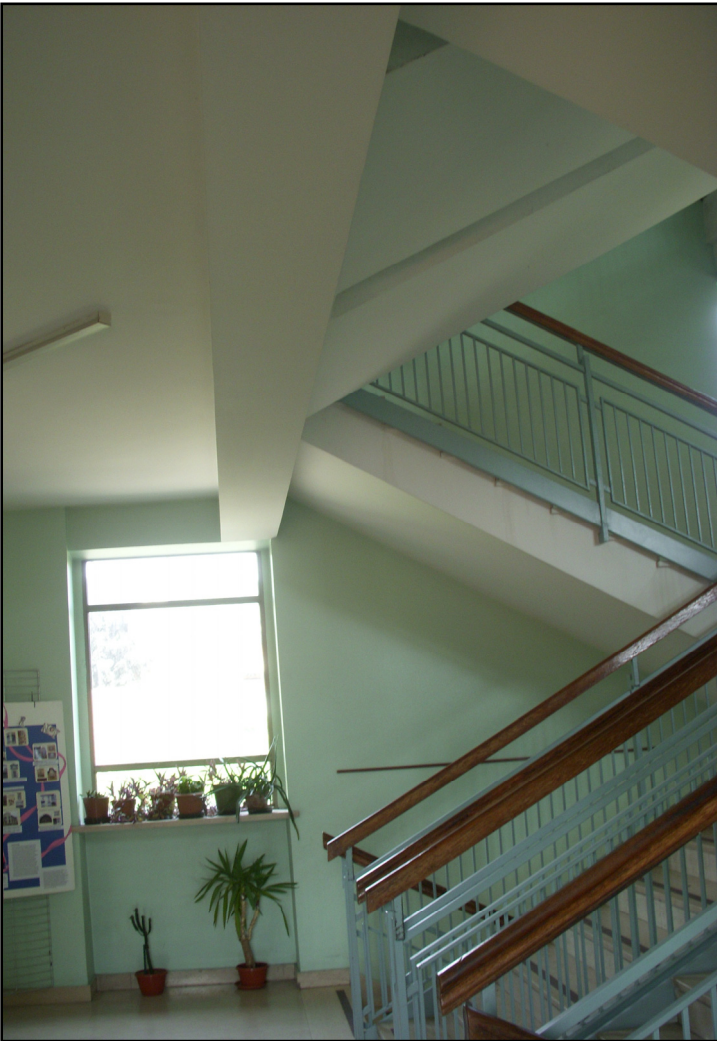
Figura 5 - Collegamento strutturale delle rampe scala
