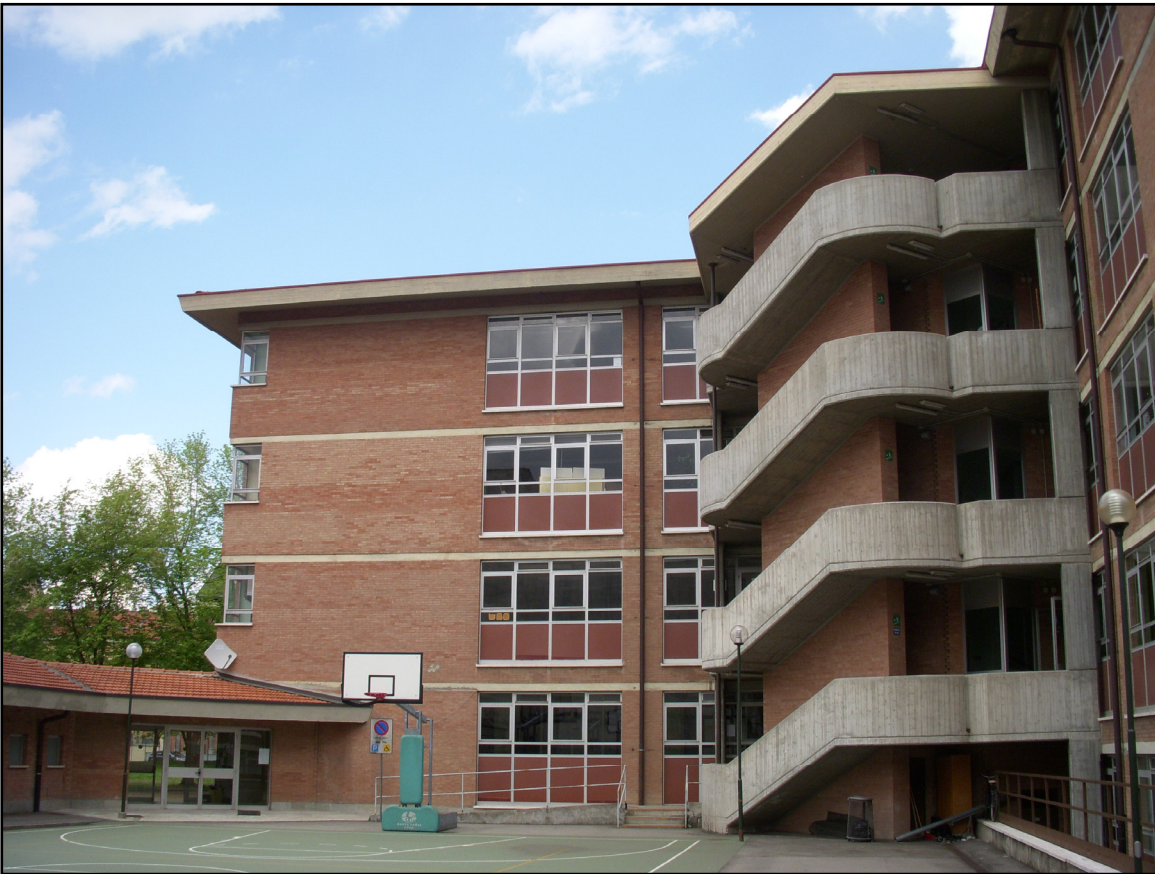
Figura 3 - Prospetto lato cortile interno (corpo 2 e scala di sicurezza)
