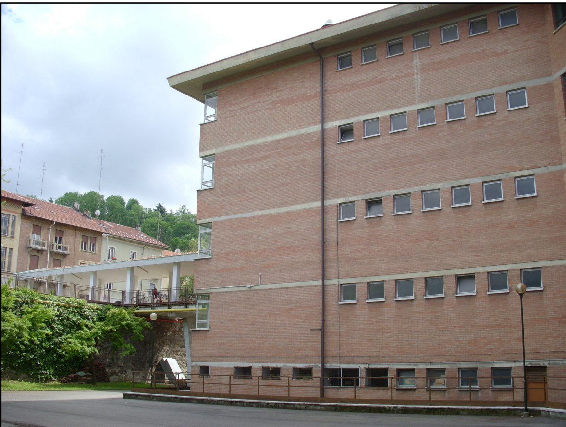
Figura 2 - Prospetto nord della scuola (corpo 1)
