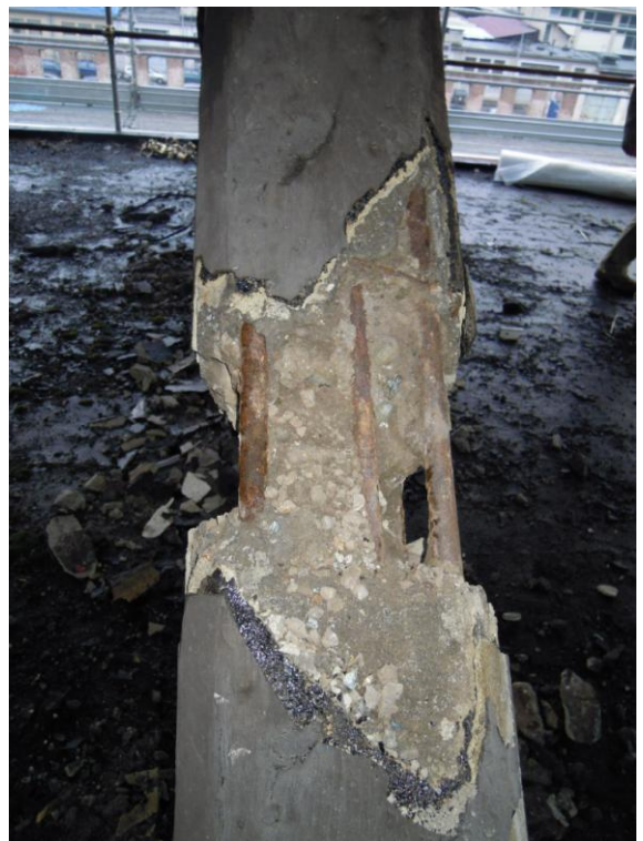
Sondaggio elementi reticolare copertura
