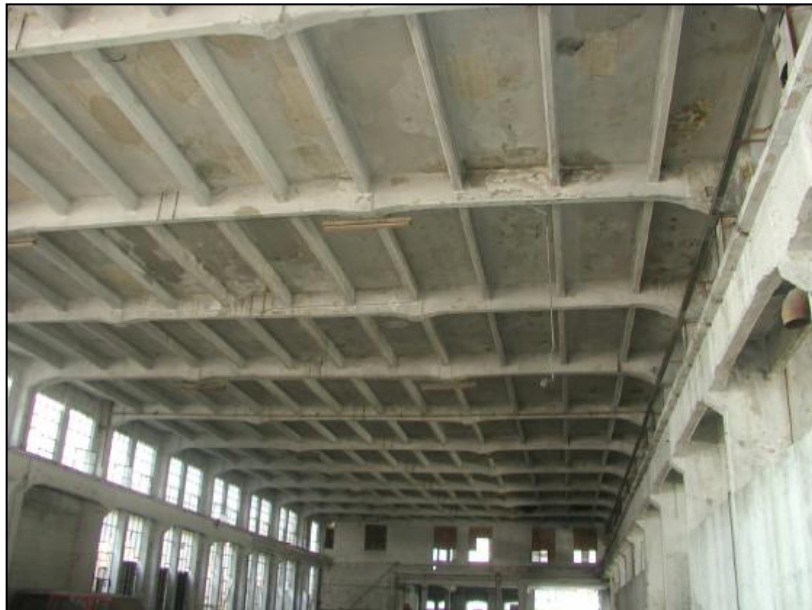
Capannone C3 – carpenteria solaio P1.
