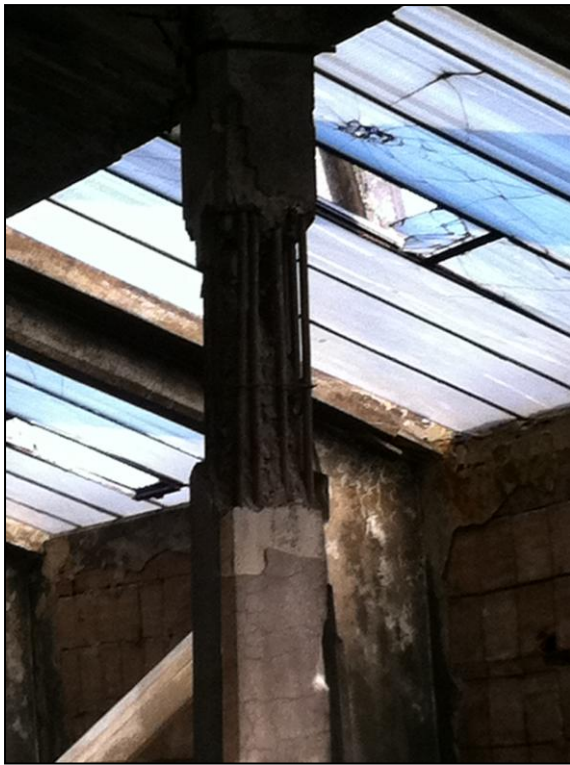
Sondaggio pilastro P1
