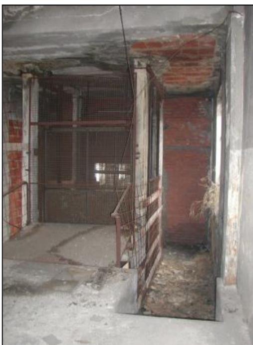
Corpo NORD – spazi interni adiacenti la scala
