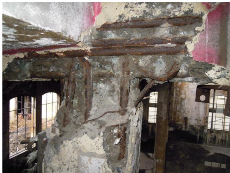
Sondaggio elementi reticolare copertura
