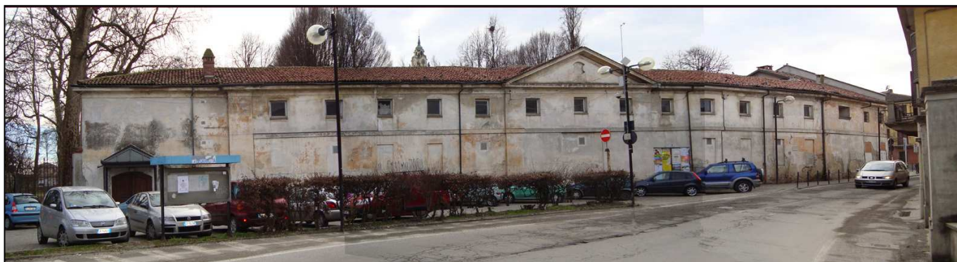
vista della manica centrale, lato strada
