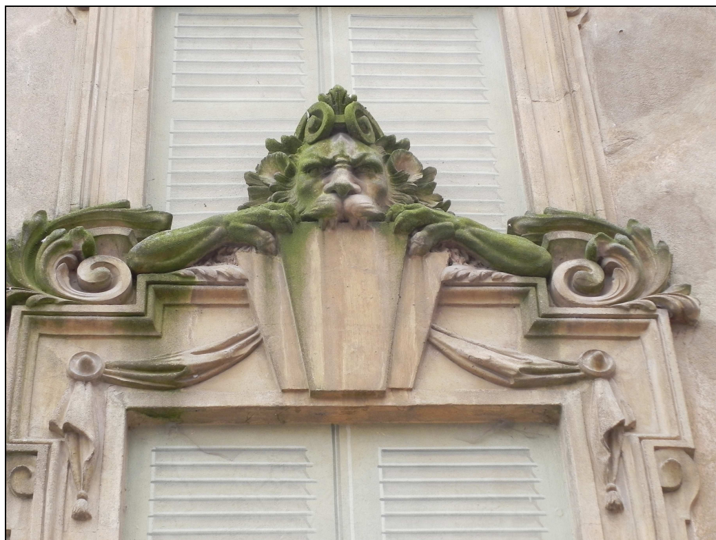
Particolare del calco sulle finte finestre del piano primo.
