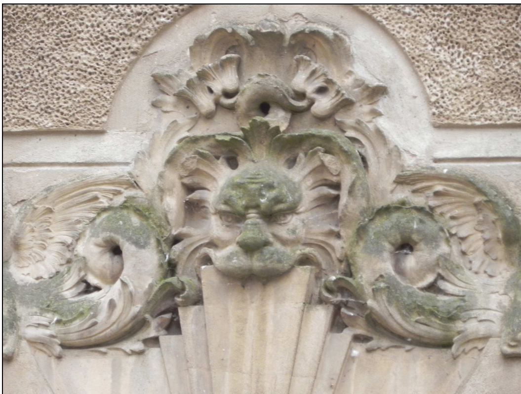
Particolare del calco inserito nel bugnato sulle finestre del piano terra.
