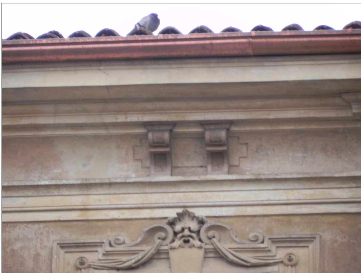
Particolare del calco sopra le finestre del piano terzo delle mensole sul cornicione.
