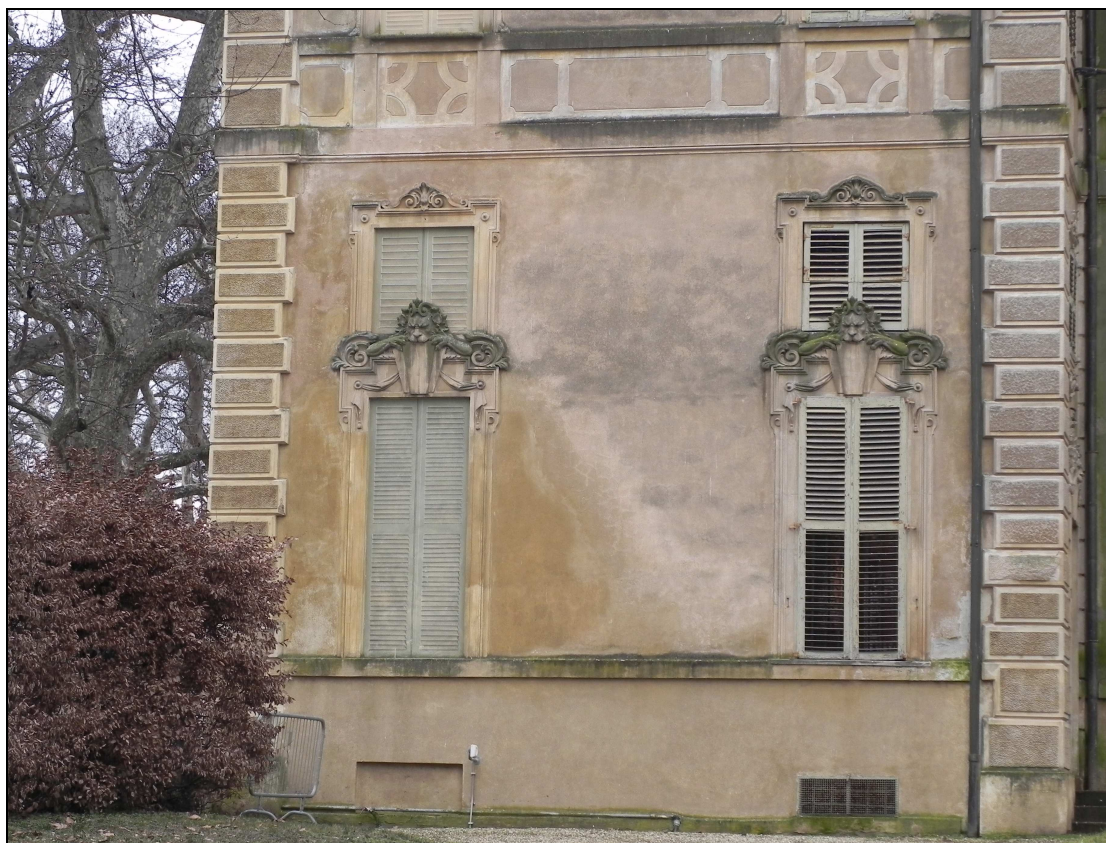
Particolare della finta finestra piano primo.
