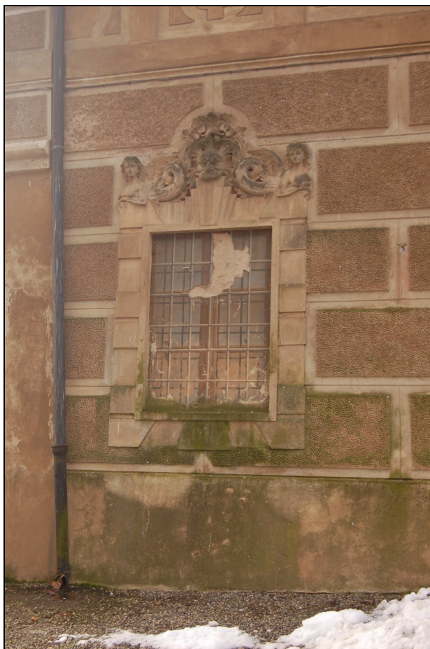
Particolare della finta finestra del piano terra.
