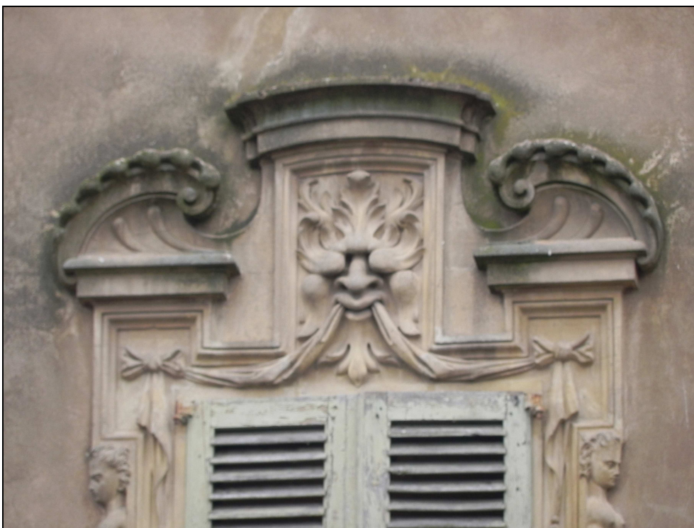
Particolare del calco sopra le finestre del piano secondo.
