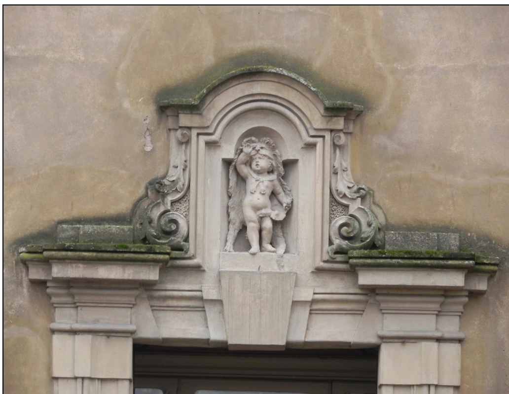
Particolare del calco sopra la porta principale d'ingresso.
