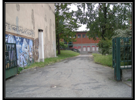
CARRAIO DA STRADA S. MAURO 26
