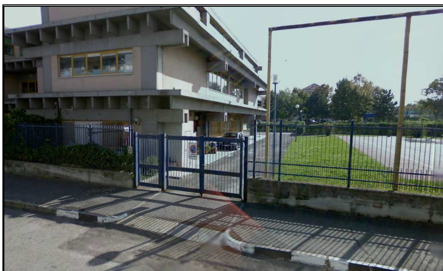
INGRESSO CARRAIO CORTILE VIA PASSONI 15
