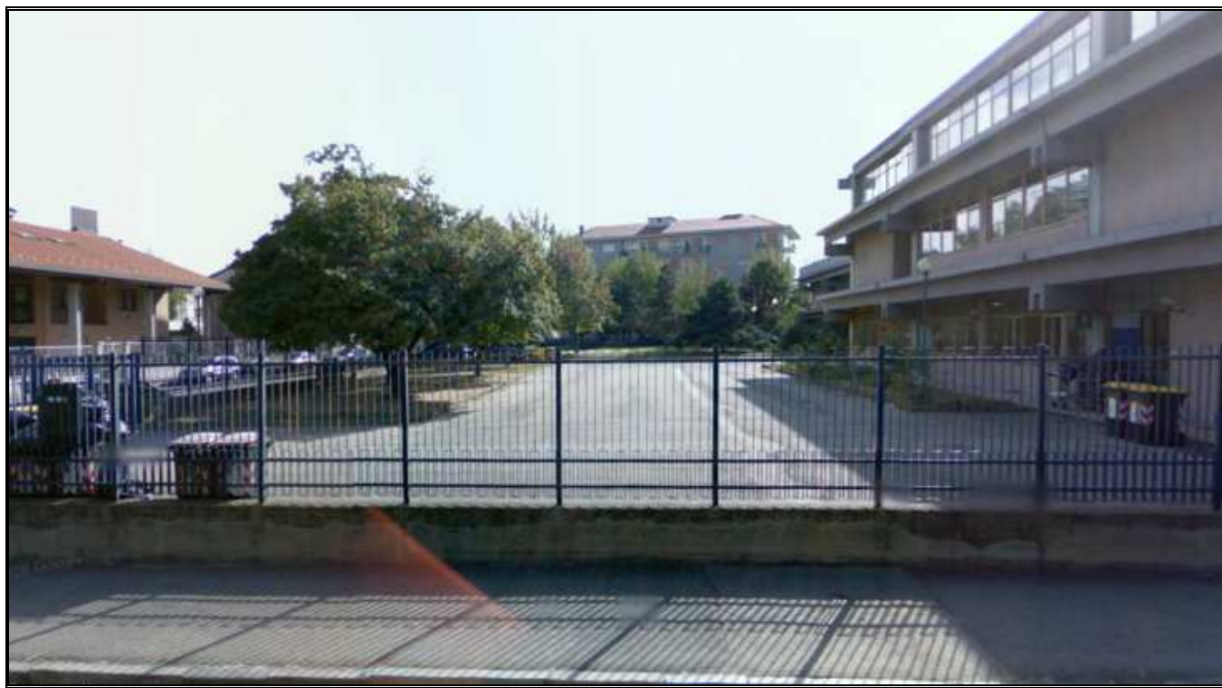
CORTILE LATO VIA PERAZZO
