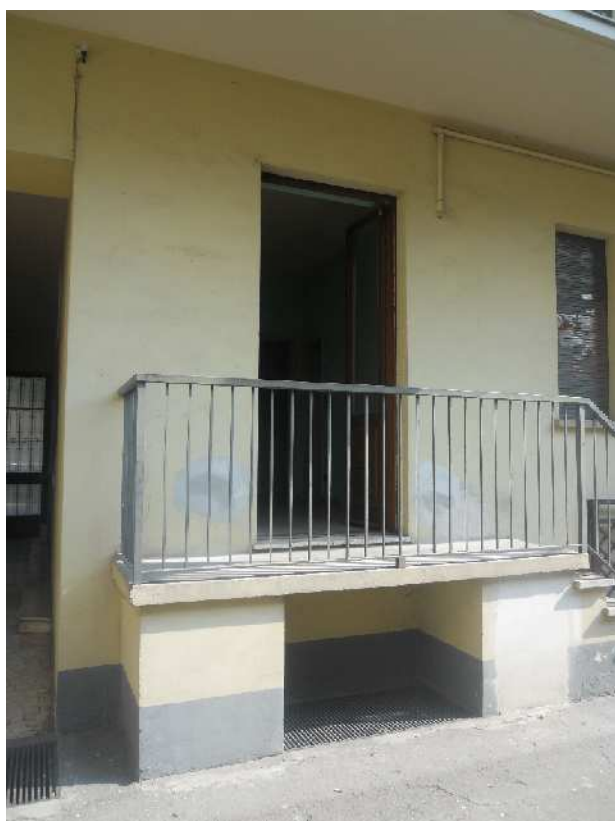
balcone ex portineria lato cortile
