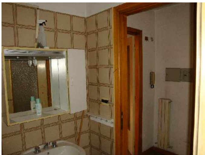
vista su bagno esistente da ristrutturare
