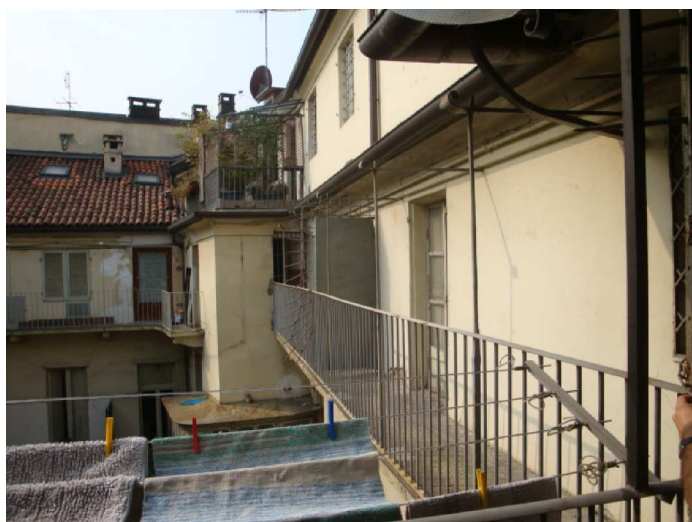
vista unità immobiliare lato ballatoio
