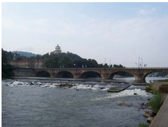
Salto idraulico esistente
