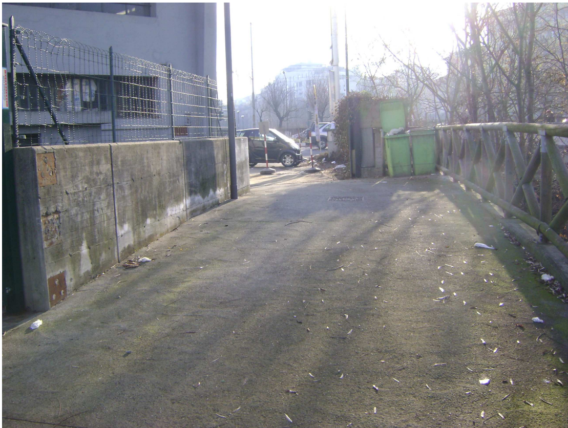
Cancelli in corrispondenza del ponte Candido Ramello sulla Dora
