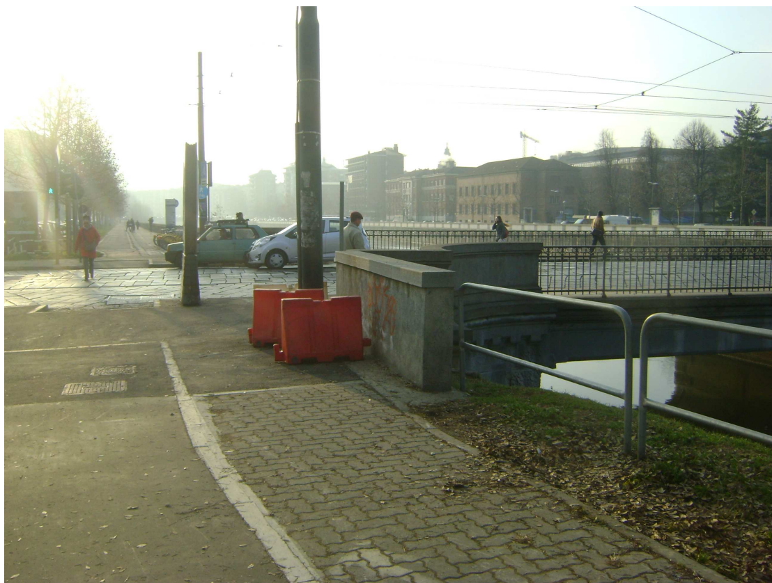
Messa in sicurezza sponde tra ponte via Bologna e ponte Mosca sulla Dora
