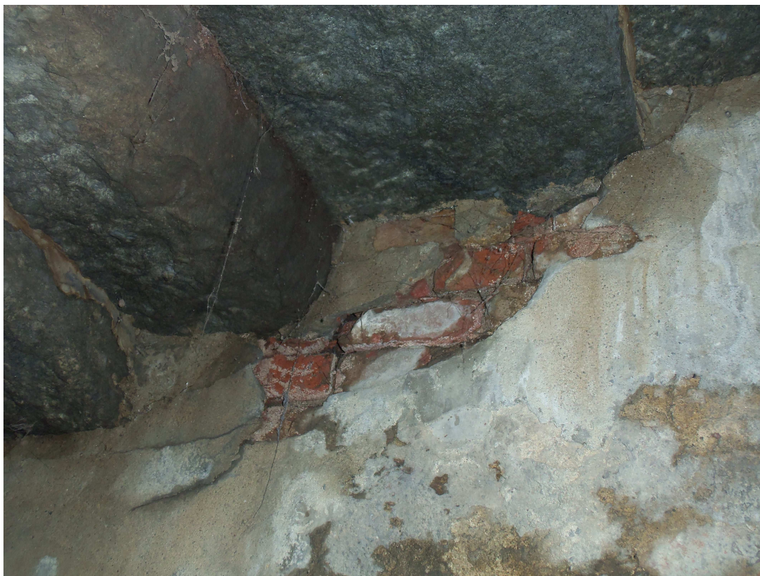
foto 58 vista interna dell'attacco gradino/muro
