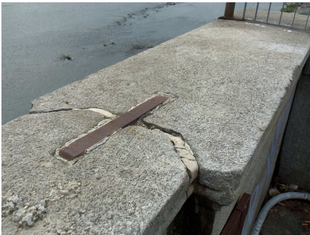
foto 28 legatura metallica tra cimasa del modulo 93 e pilastrino scalaC/93
