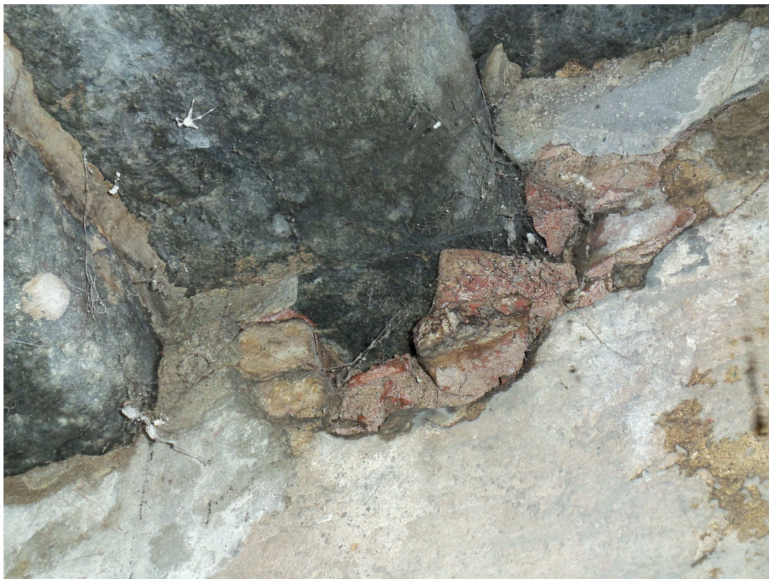
foto 57 vista interna dell'attacco gradino/muro
