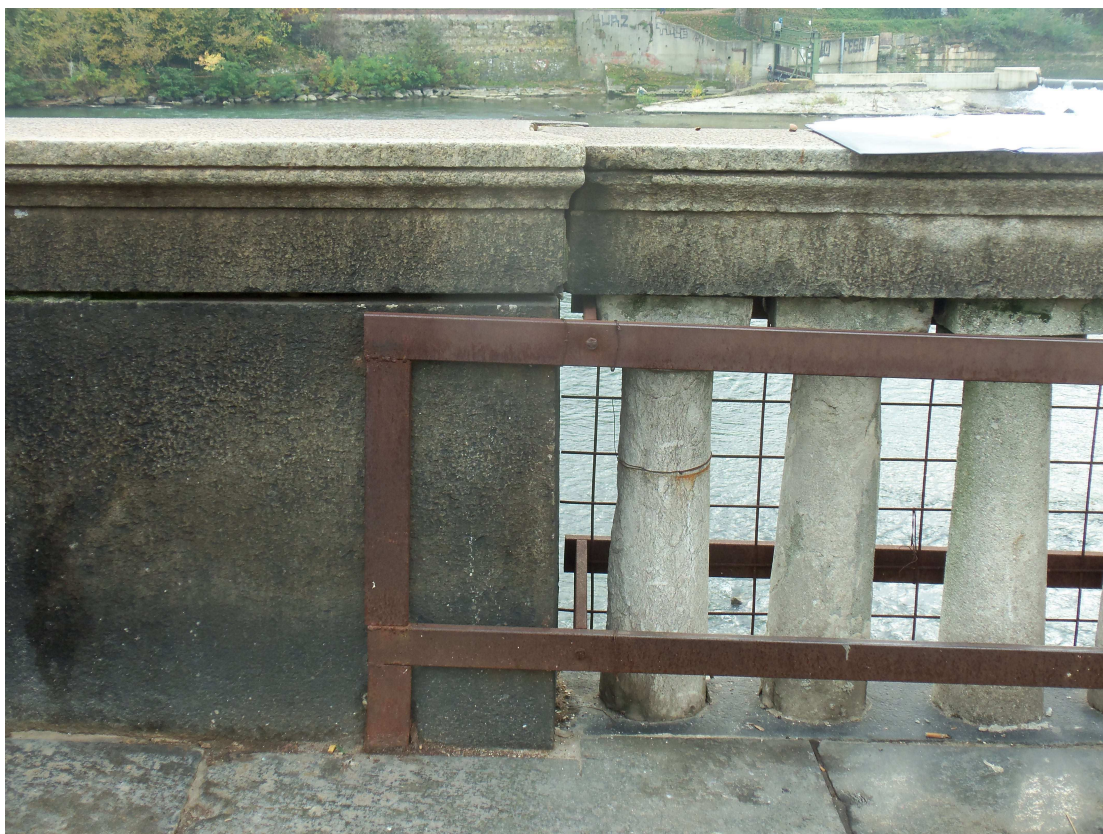
foto 13 cimasa del modulo 85 sconnesso con il pilastro 85/scala
