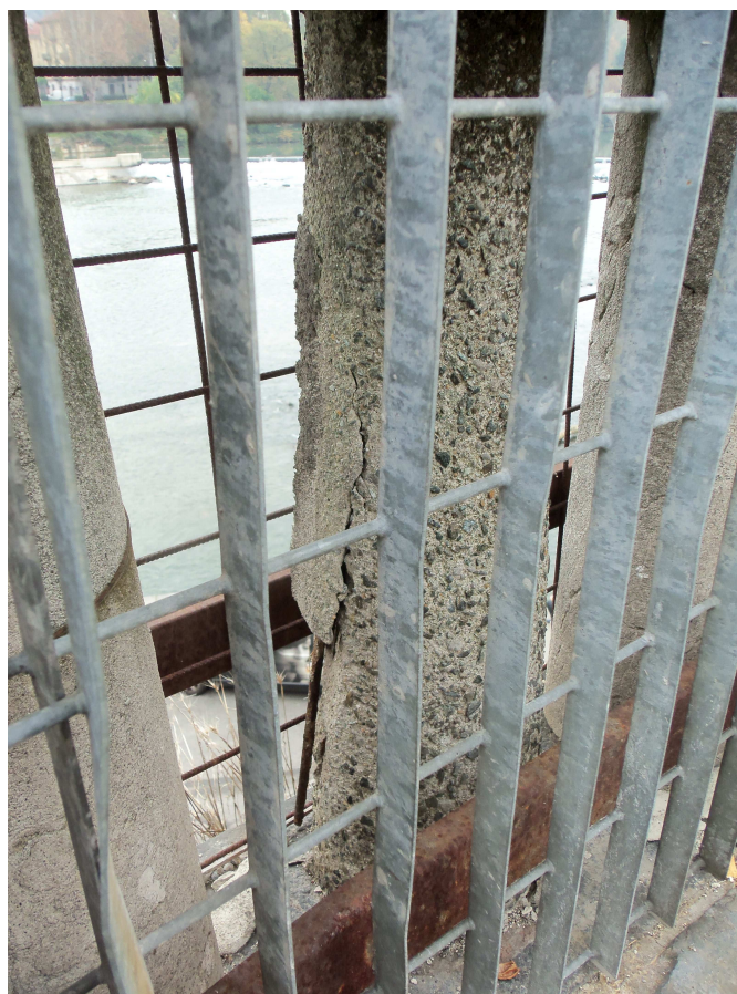
foto 20 colonnina in cls nel modulo 88
