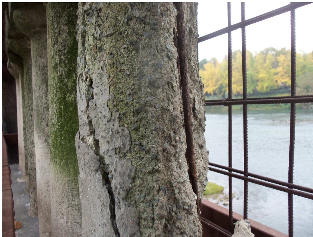
foto 21 colonnina in cls nel modulo 89
