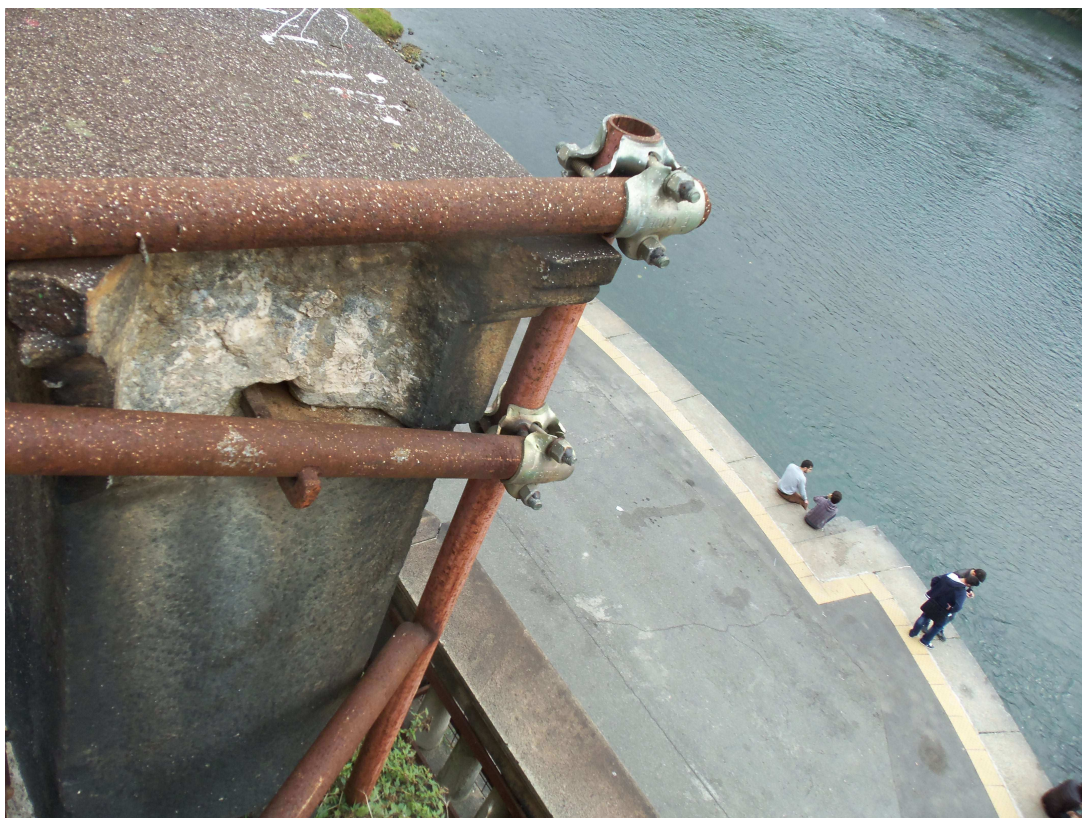
foto 17 pilastro 87/88 con gancio di collegamento con cimasa modulo 87
