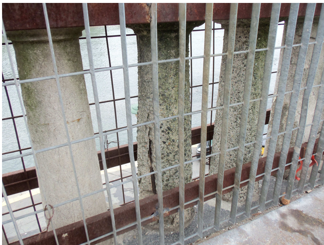
foto 22 colonnine in cls nel modulo 89
