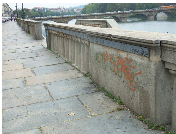
intervento di consolidamento delle cimase nel modulo 63
