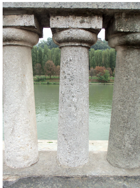
tipi diversi di colonnine nel modulo 46
