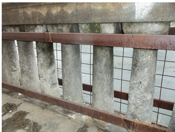
colonnine erose e lesionate nel modulo 81
