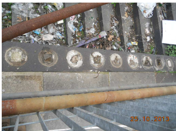
modulo 86 - sedi alla base delle colonnine
