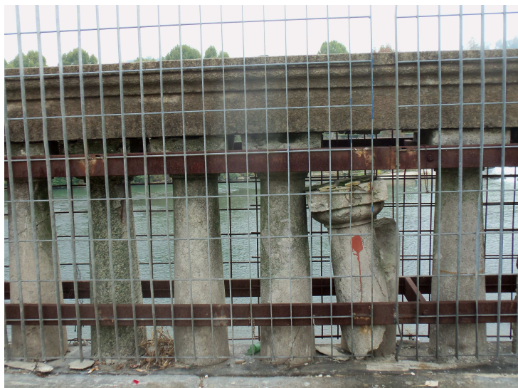
colonnina rotta nel modulo 88
