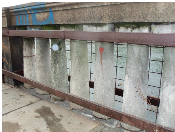
modulo 83 – attacco delle colonnine alla cimasa
