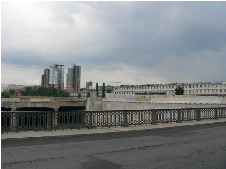
Foto 4 - spalla nuovo ponte lato nord
