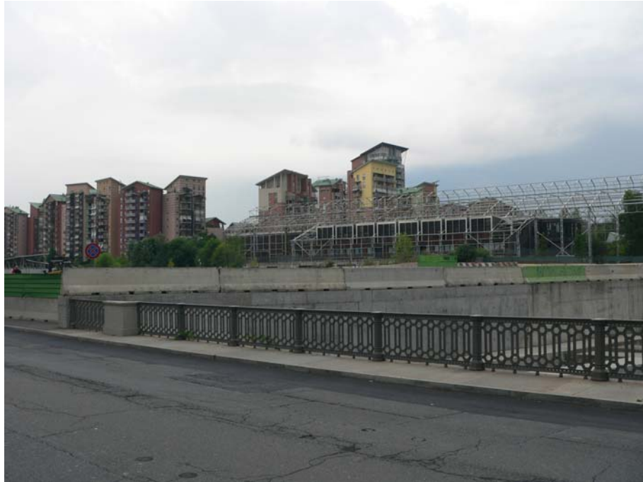
Foto 5 - spalla nuovo ponte lato sud
