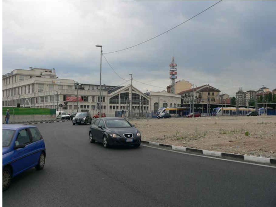
Foto 7 - Piazza Baldissera – limite nord dell'intervento
