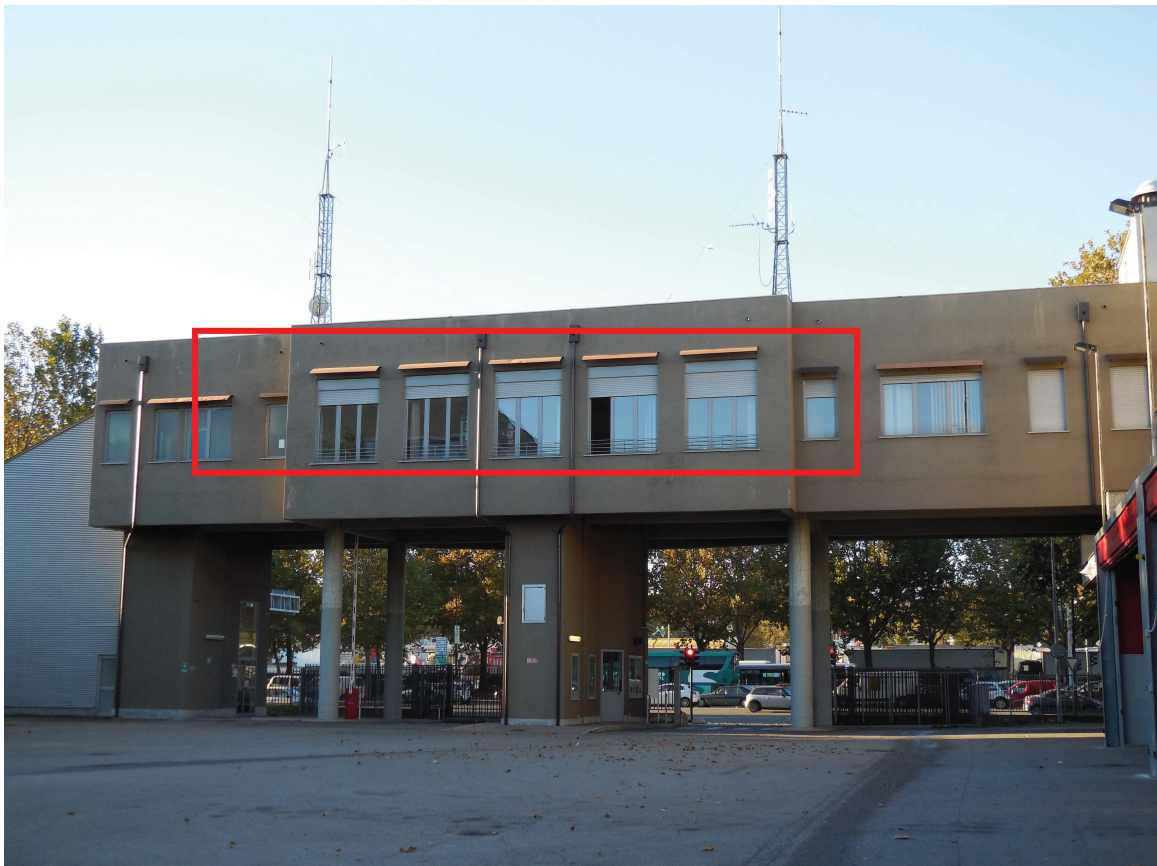
Foto 6 – Sala operativa fronte cortile – Serramenti vetrati su cui effettuare la manutenzione
