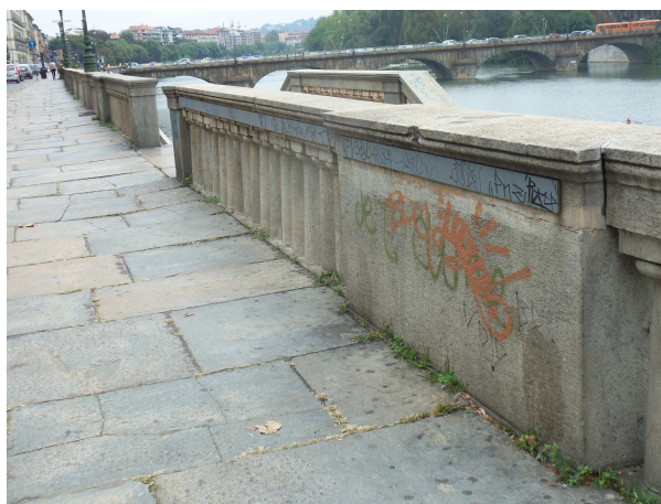
intervento di consolidamento delle cimase nel modulo 63
