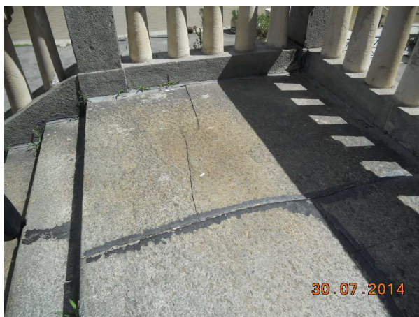
pianerottolo e gradino rotto nel modulo F - scala A
