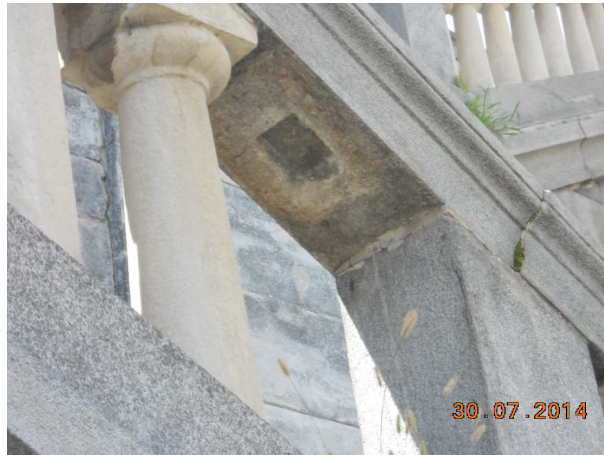
scala A modulo G – attacco delle colonnine alla cimasa
