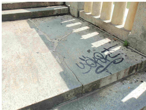
colonnine del modulo E – scala B
