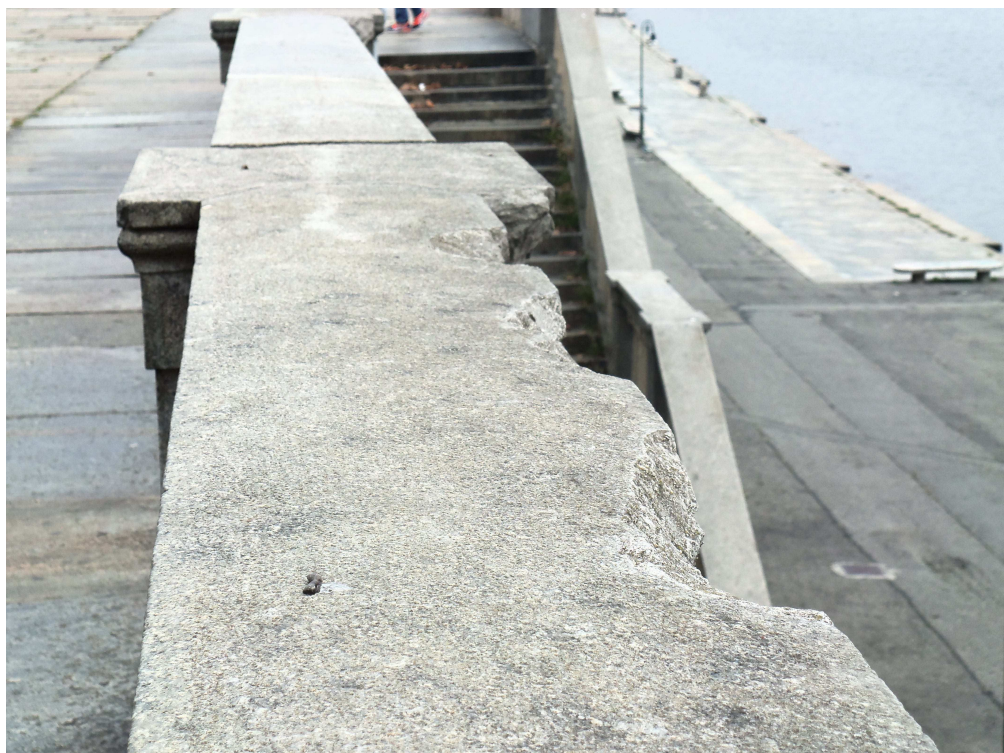
foto 09 partì mancanti della cimasa del modulo 13
