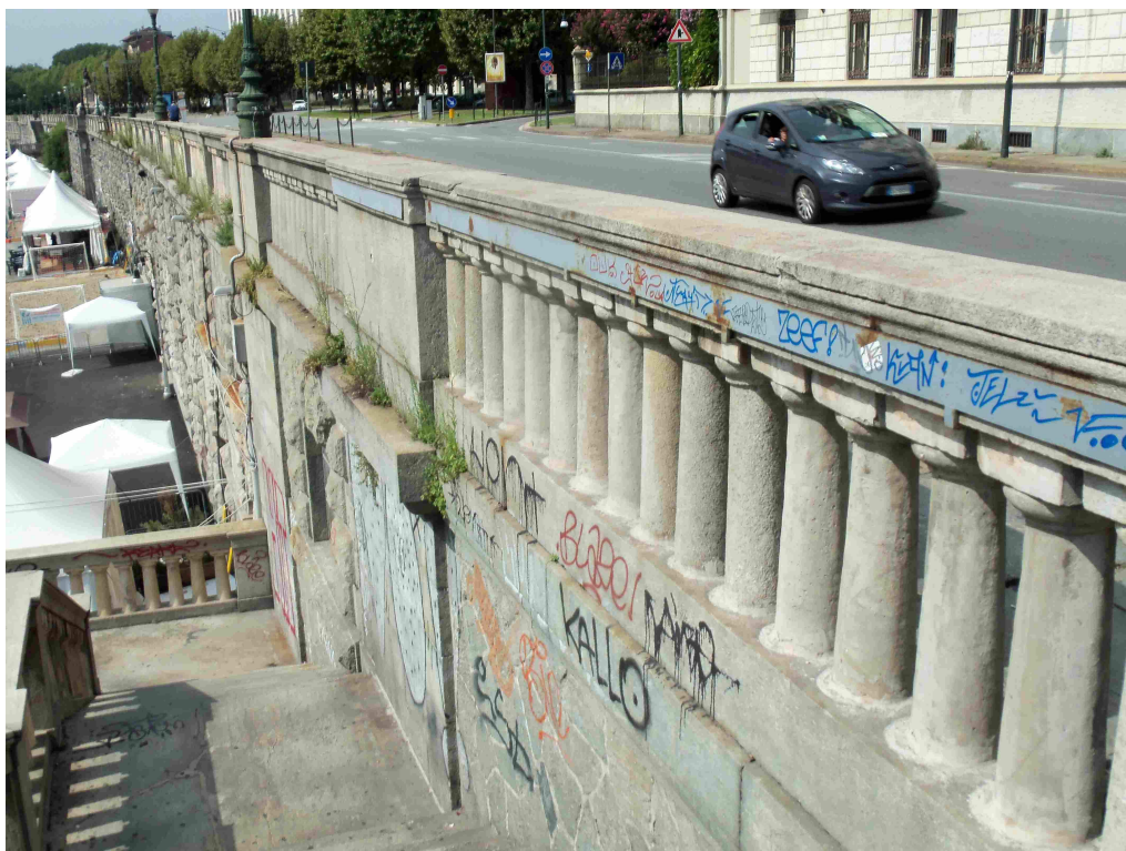
foto 69 consolidamento con carpenteria metallica su entrambi i lati del modulo 63
