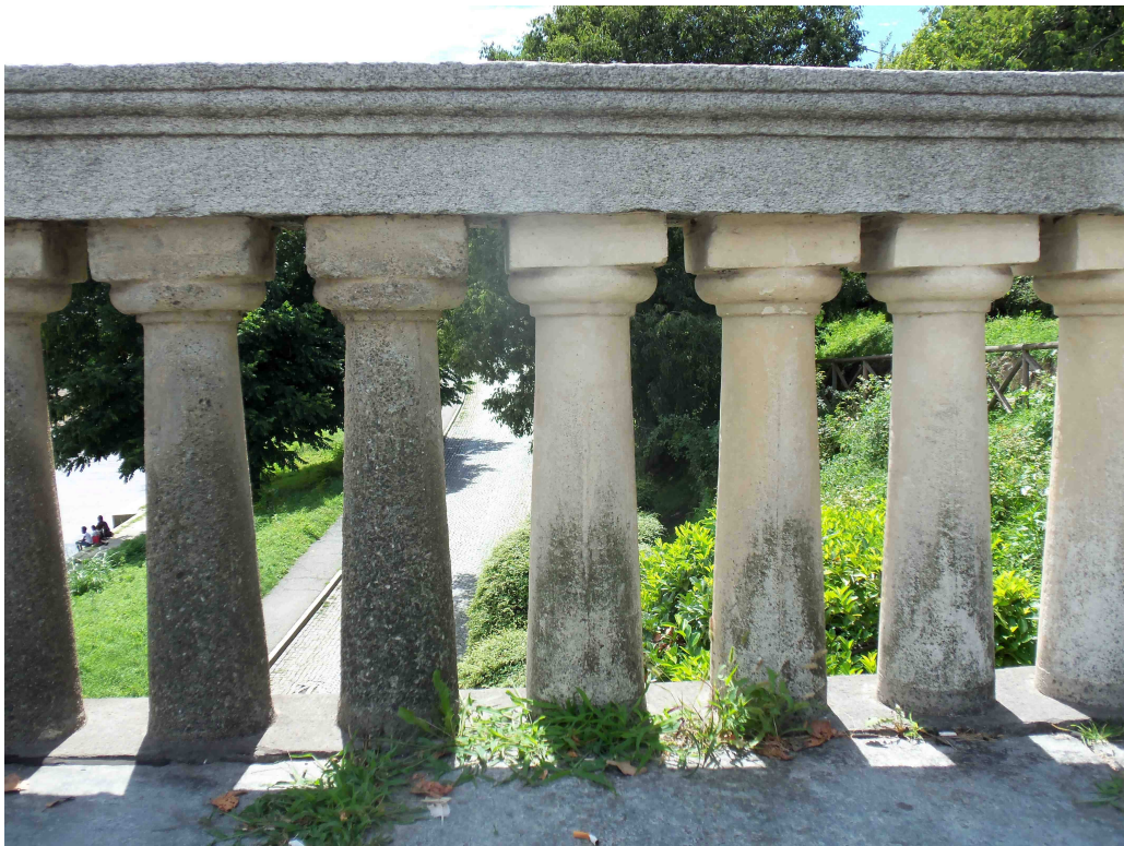
foto 02 tipologie diverse di colonnine in cls nel modulo 2
