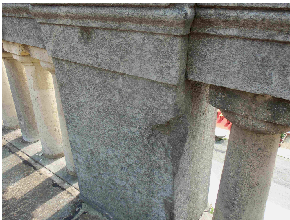
foto 60 parte mancante dell'angolo del pilastrino 47/48
