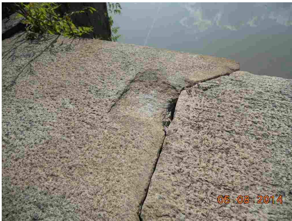
foto 87 parte mancante della sommità del pilastrino terminante il modulo 75
