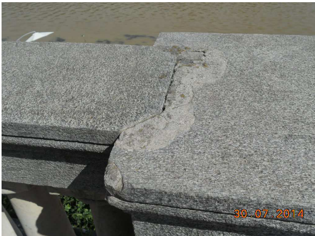
foto 36 ripristini e sigillature in cls alla sommità del pilastro 31/32
