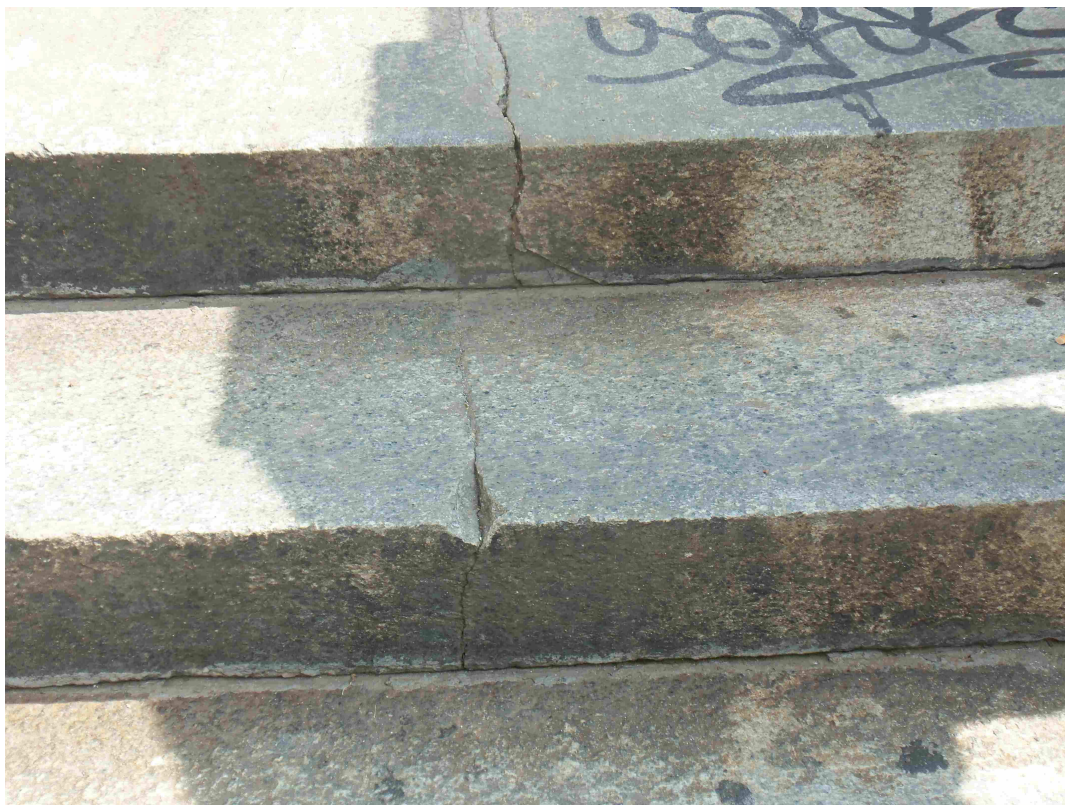
foto 75 1° gradino a scendere del modulo D della scala B rotto
