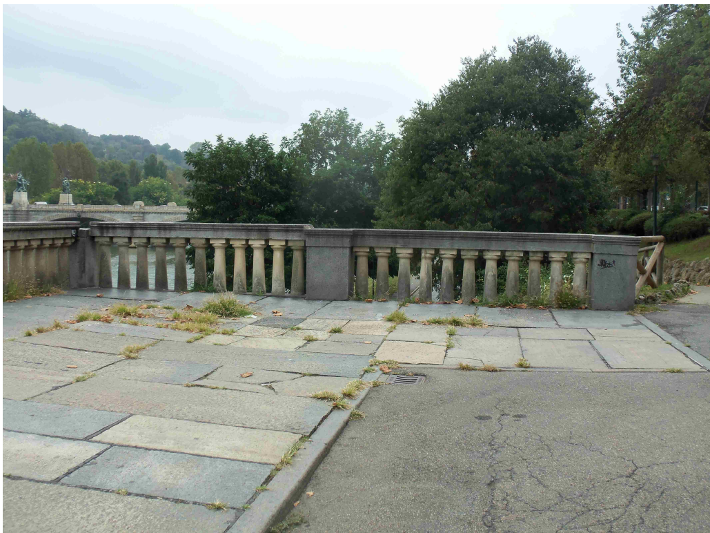
foto 01 disallineamento della cimasa del modulo 2
