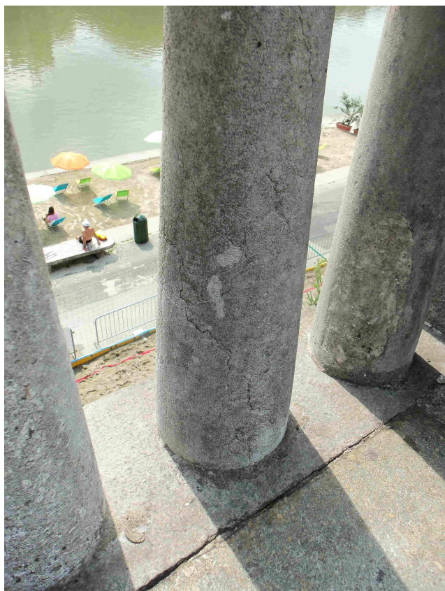
foto 57 colonnina lesionata nel modulo 46
