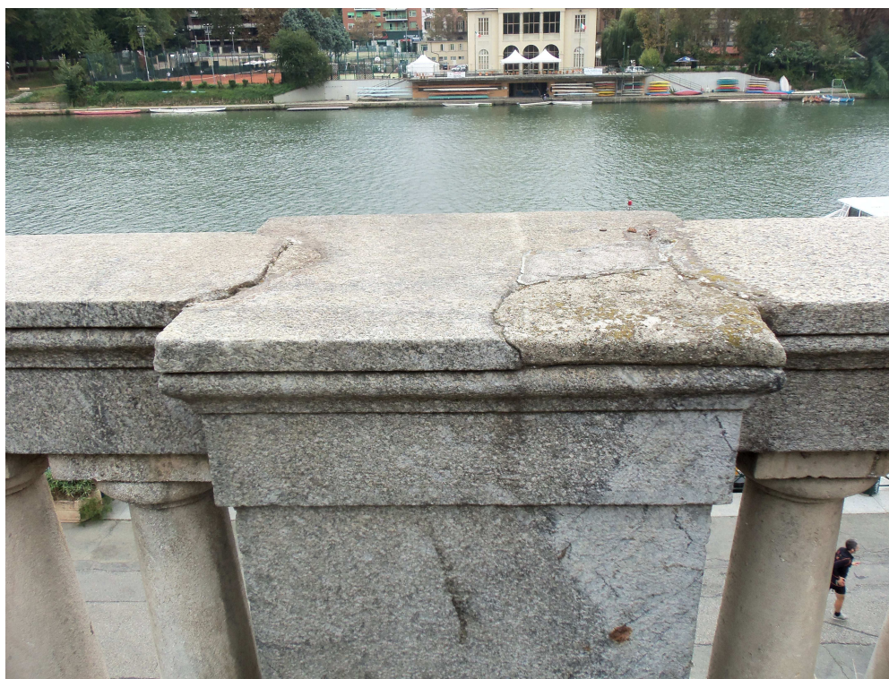
foto 06 ripristino in cls di parte del pilastrino 10/11
