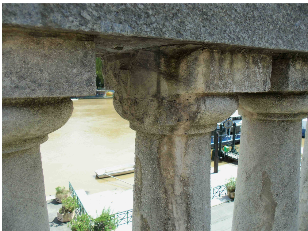
foto 10 particolare di un capitello eroso nel modulo 14
