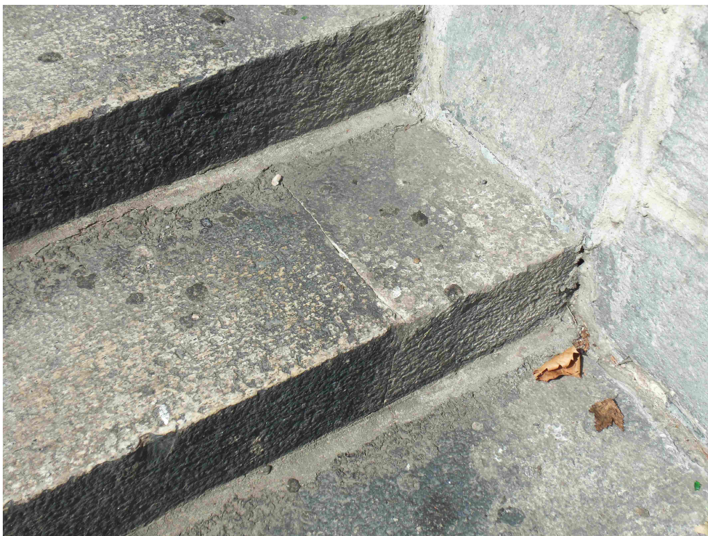
foto 79 2° gradino a scendere del modulo L della scala B rotto
