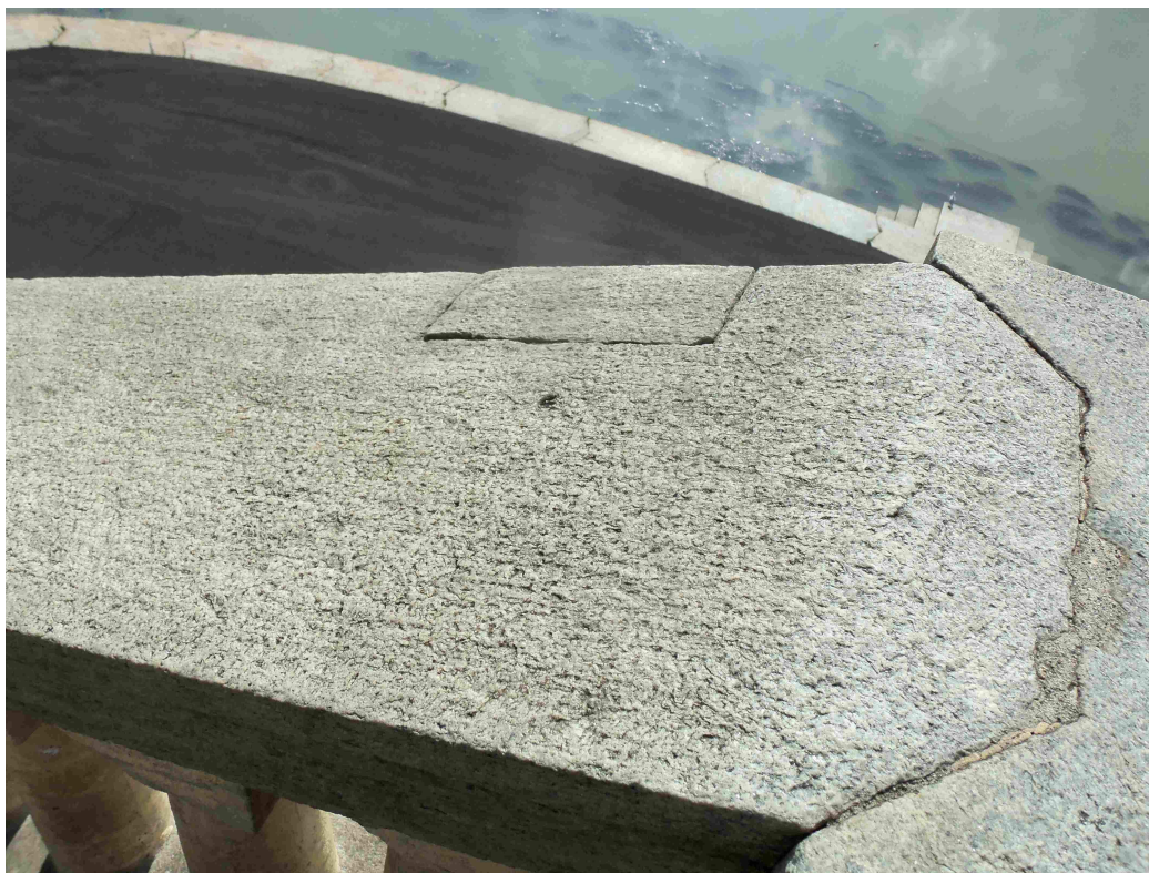
foto 78 tassello in pietra nella cimasa del modulo I della scala B
