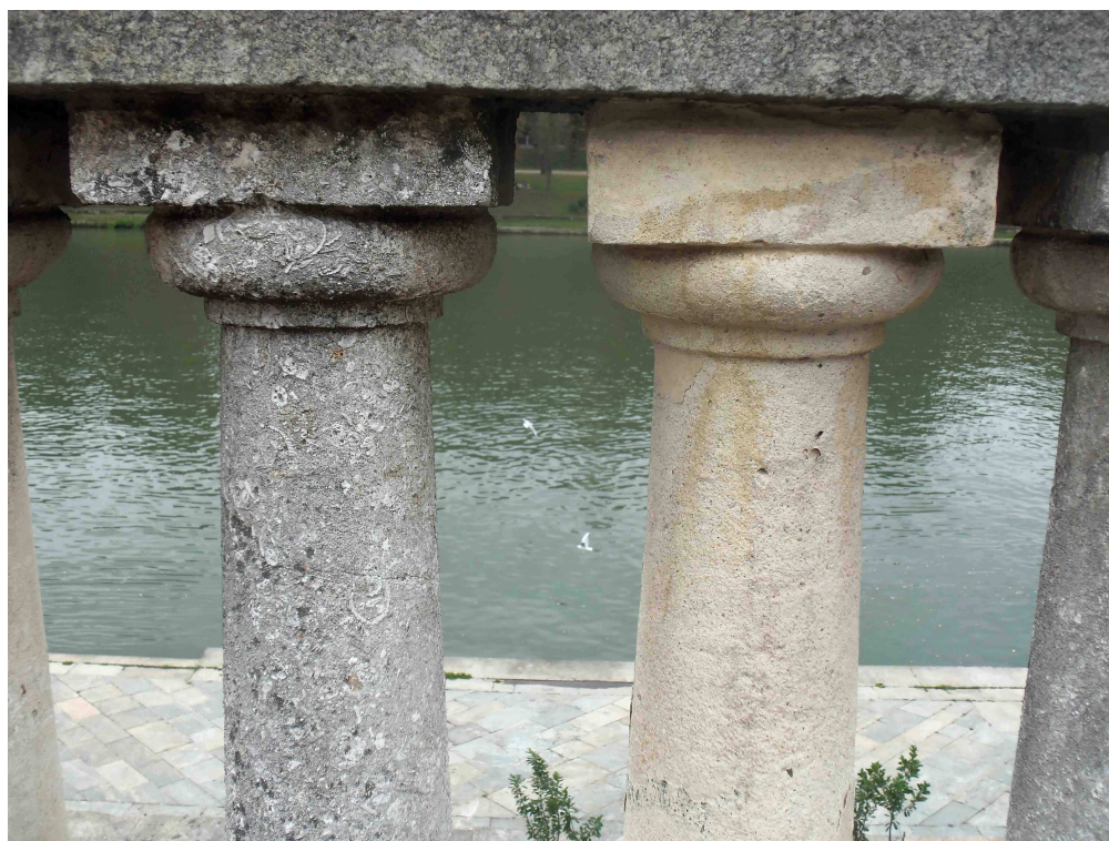
foto 58 colonnine in pietra di Saltrio e in pietra di Finale nel modulo 46
