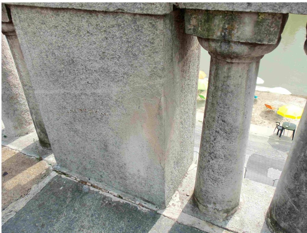
foto 51 ripristini in cls del pilastro 42/43
