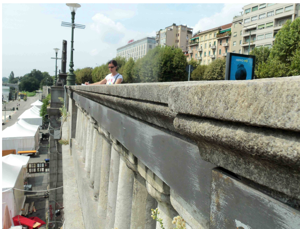
foto 54 consolidamento con carpenteria metallica dei moduli 42 e 43
