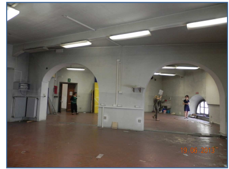
I locali a piano secondo
