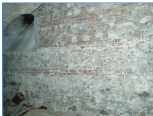
La struttura muraria in vista
