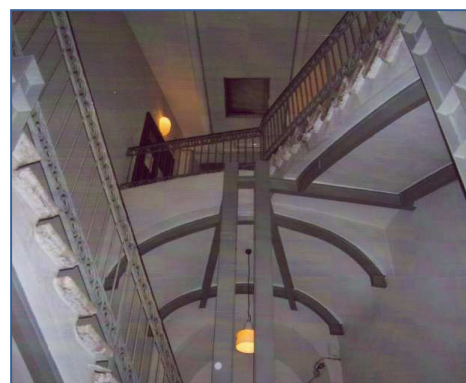
La struttura metallica di rinforzo dello scalone
