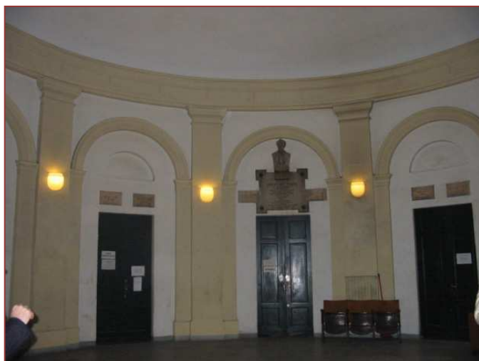
L'apparato decorativo del vestibolo centrale
