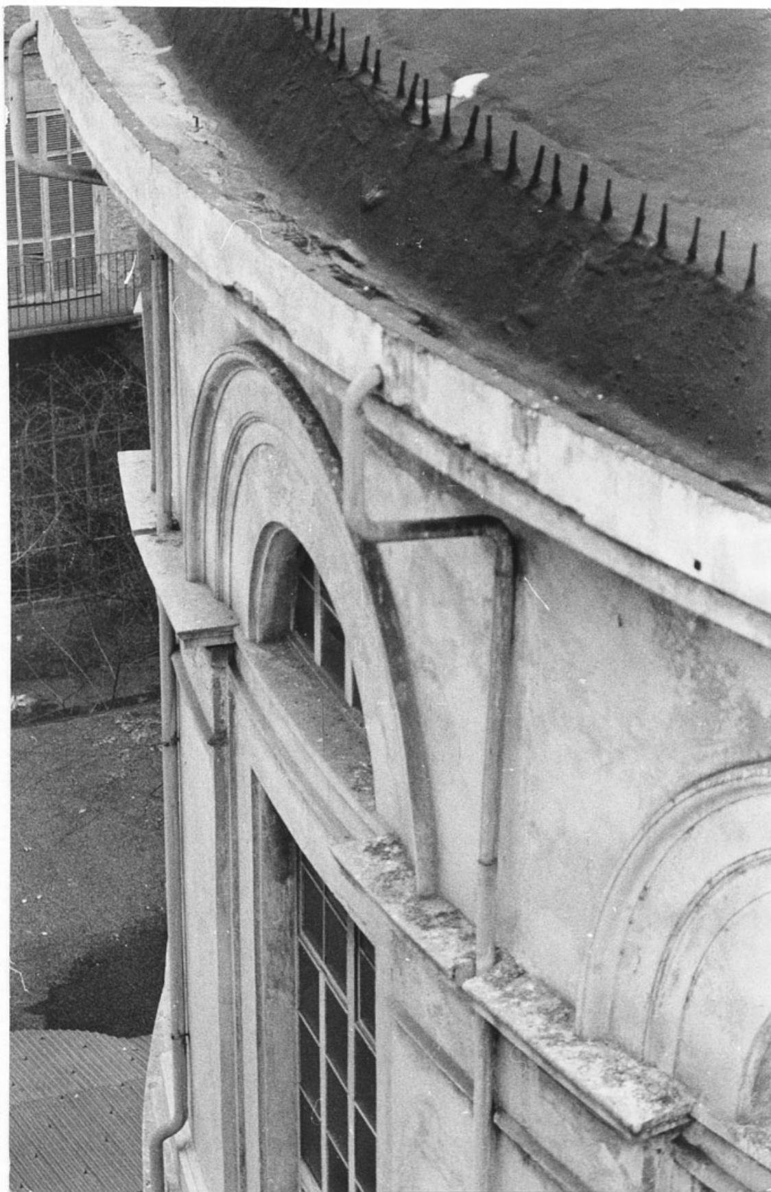
fig. 26) Particolare della Rotonda, s.d. (ASCT, Archivio fotografico, fondo CRDC FT 14D10_117)
