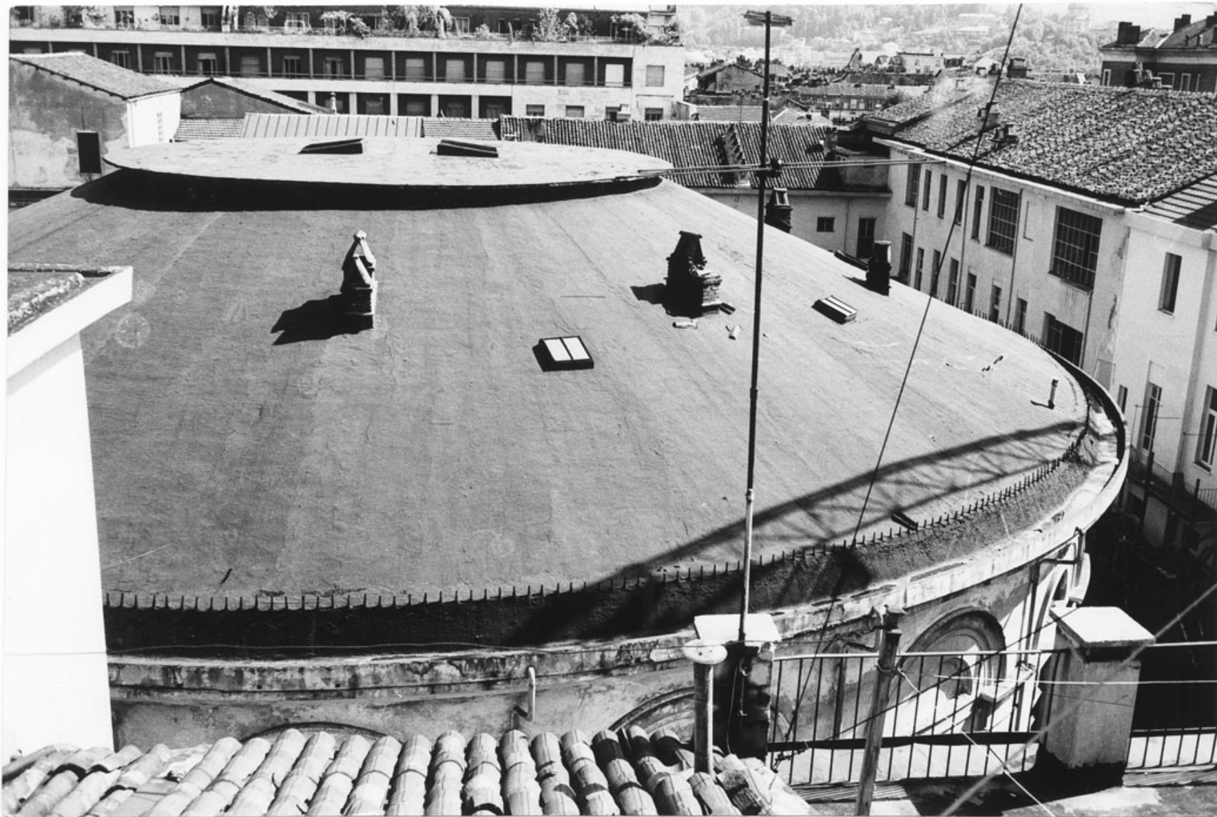
fig.25) La copertura della Rotonda ripresa dal tetto dell'edificio di via San Francesco da Paola, s.d. (ASCT, Archivio fotografico, fondo CRDC , FT 14D10_007)
