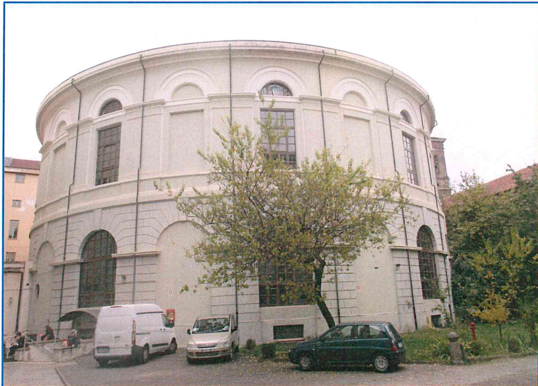
Vista del fabbricato
