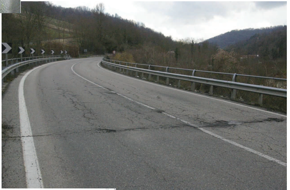
impalcato viadotto visto da Torinc
