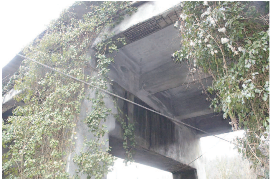
1 a campata a monte e 1 a pila lato destro
