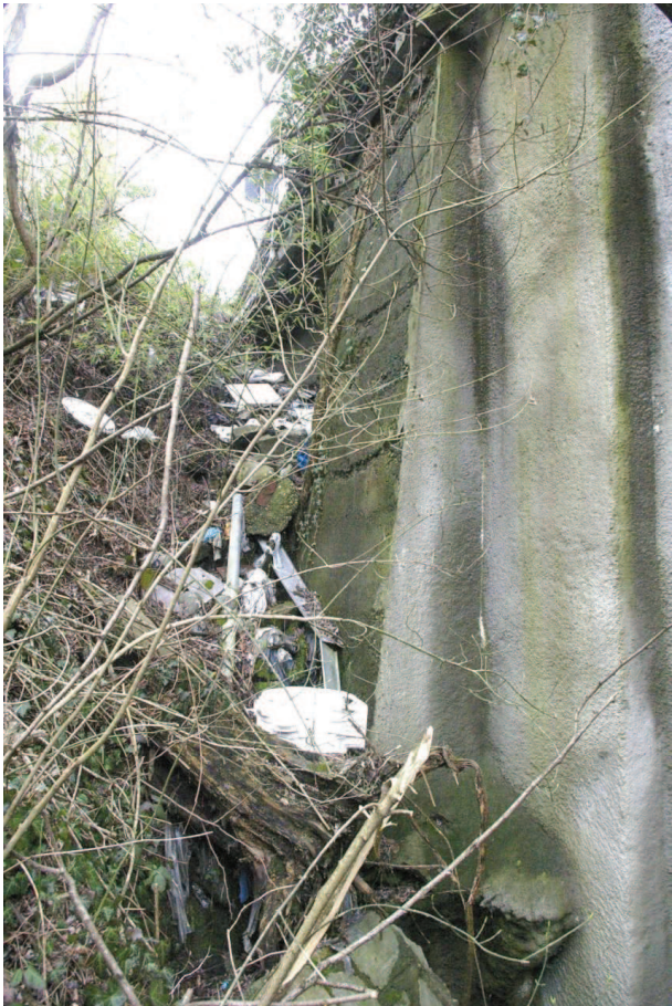
muro andatore a monte in sinistra
