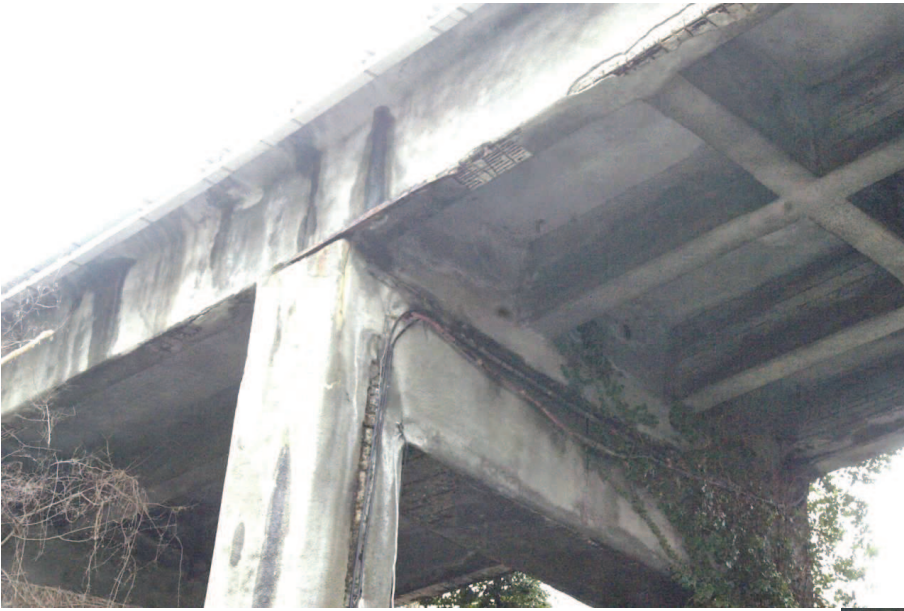
impalcato 2 a campata verso 1 a pila
