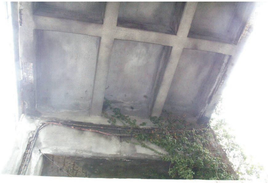
impalcato 2 a campata verso 1 a pila
