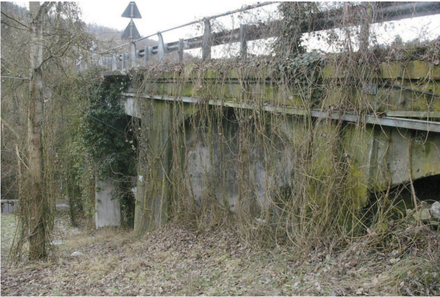
muro andatore a monte in destra
