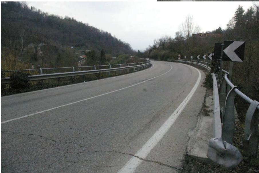
impalcato viadotto visto da Pino
