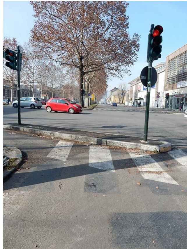
Corso Vigevano – Inizio nuova pista
