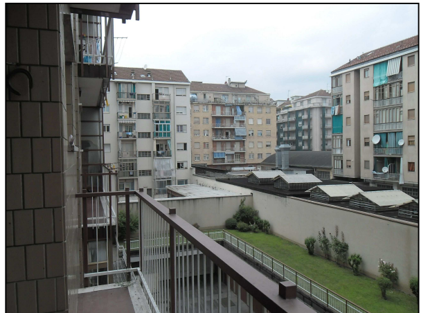
Prospetto cortile interno
