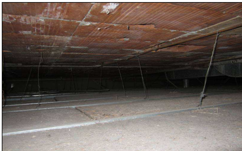
Complesso La Marchesa pendinatura della controsoffittatura in pannelli Tipo Eraclit locali sale igieniche
