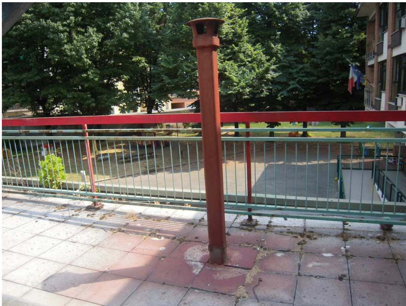
Immagine della parte sommitale di una delle canne di ventilazione in cemento amianto da rimuovere.
