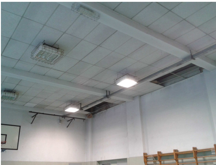
Controsoffitto della palestra
