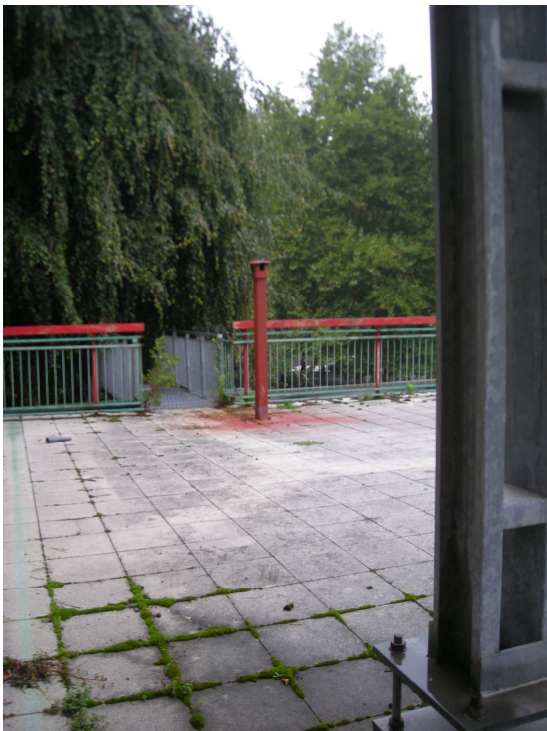
Tubi di aerazione in copertura piano rialzato
