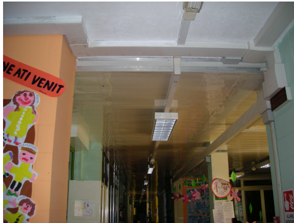
Controsoffitti a pannelli radianti
