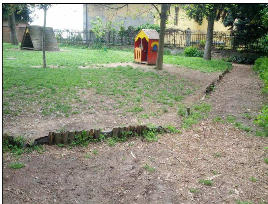
vista cordoli realizzati con tronchetti in legno
