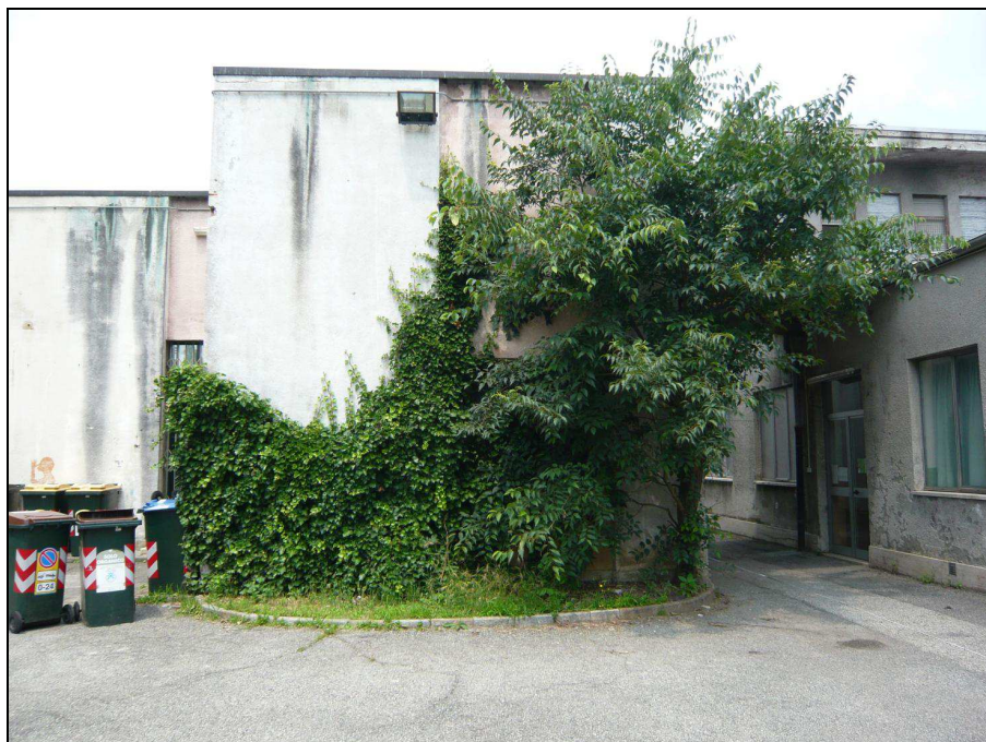
vista aiuola accesso cortile interno
