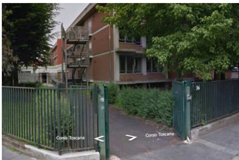
ingresso di cantiere corso Toscana 36
