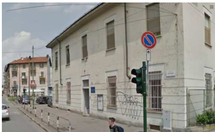
vista edificio scolastico
