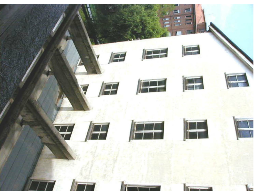
5 - PAD. III - facciata intonacata
