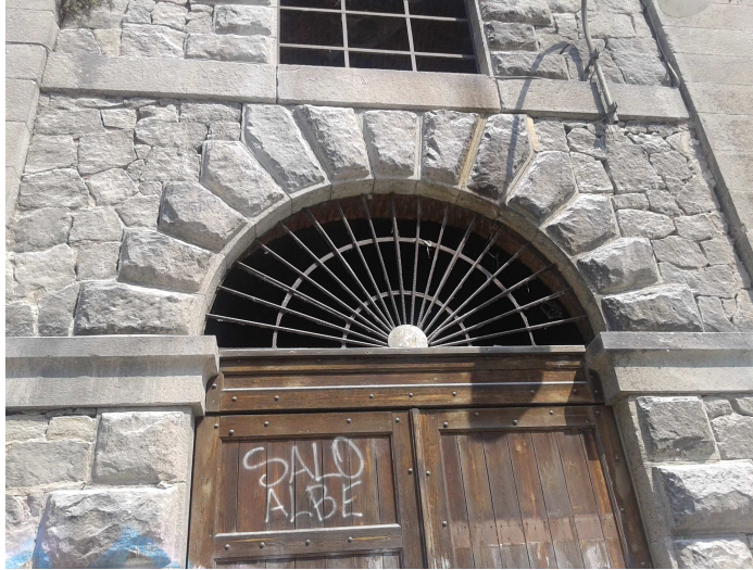
Foto 9 - Inferriata arcata 42 realizzata in tondino di ferro.
