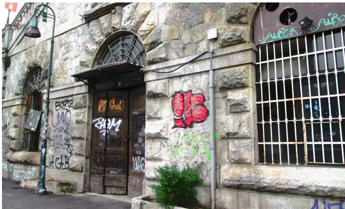
Foto 2 Portone di tipo A – Lato Corso Cairoli
