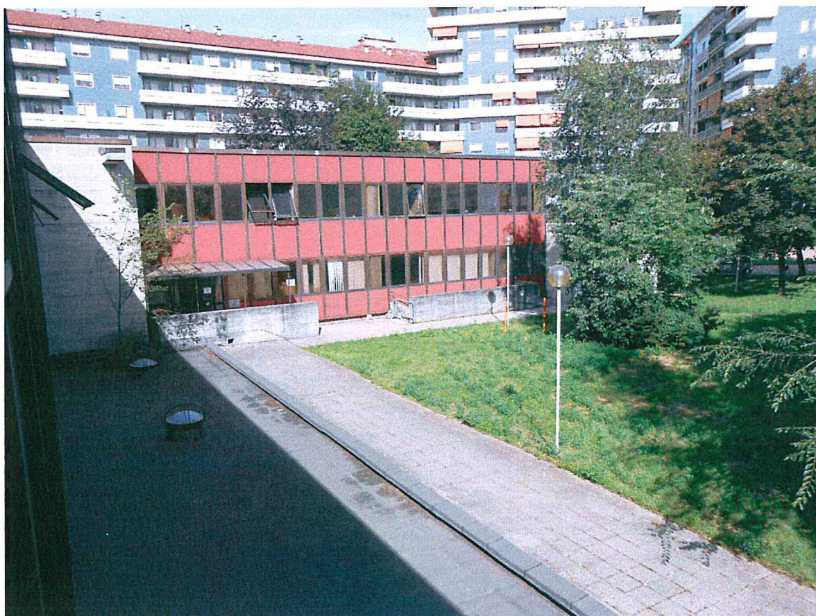
1-FACCIATA esposta a ovest
