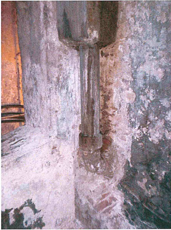
6- rimozione di tubazione contenente amianto situata nell'interrato
