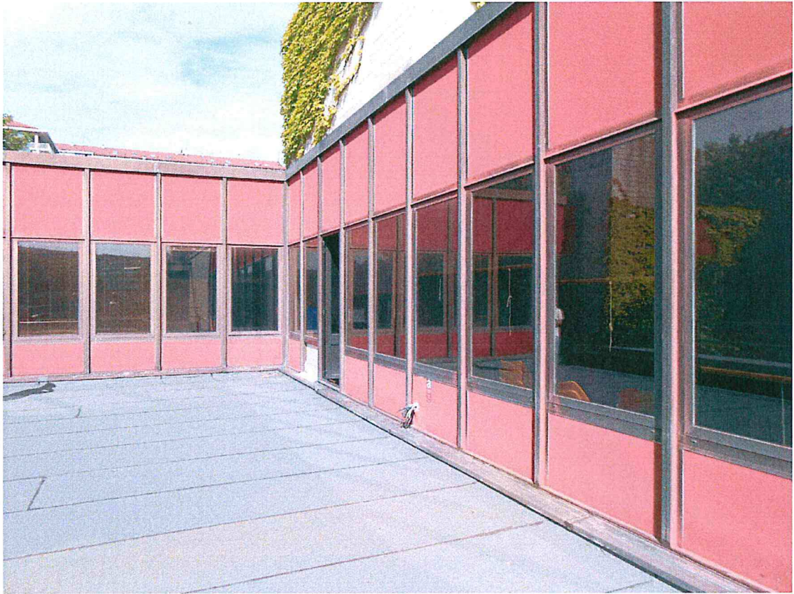
3-FACCIATA del primo piano esposta a sud
