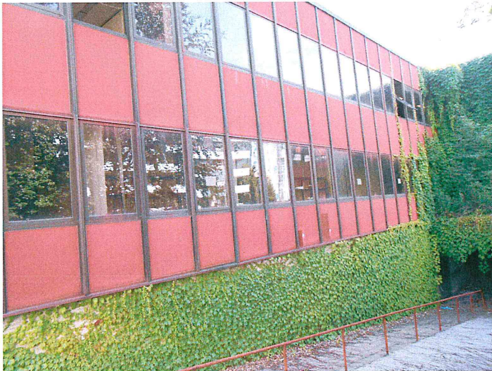
5 - FACCIATA esposta a ovest
