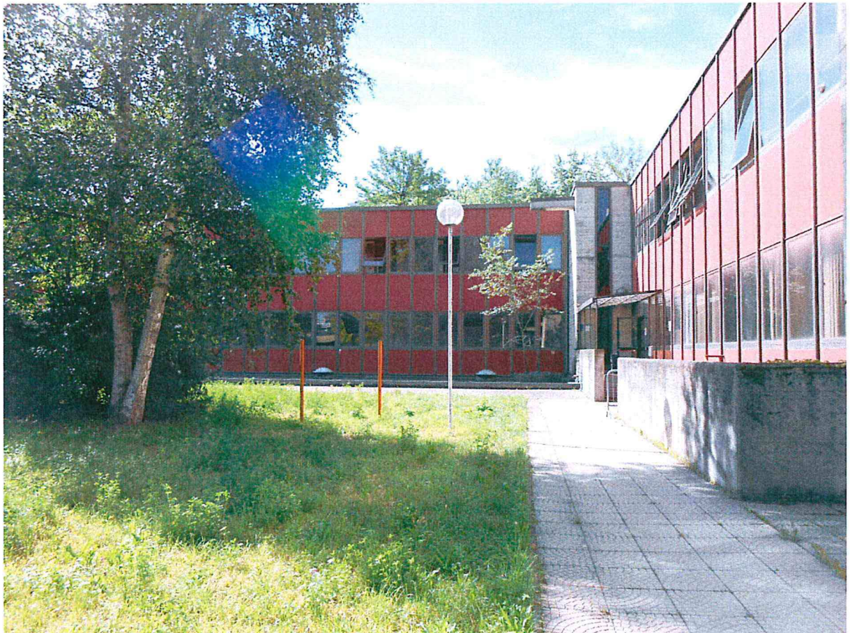
1+2- VISTA FACCIATE esposte a ovest+nord
