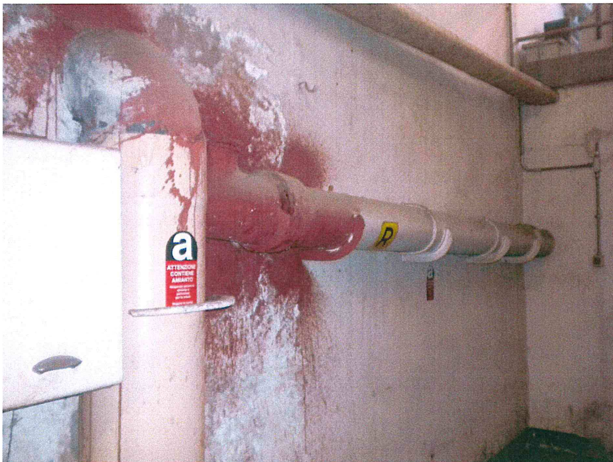
4- rimozione di tubazione contenente amianto situata nell'interrato CT
