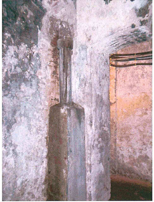
6- rimozione di tubazione contenente amianto situata nell'interrato
