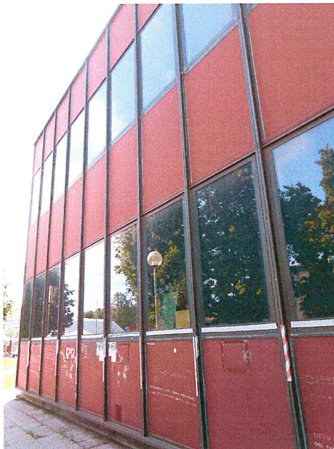
6 - FACCIATA esposta a nord - zona ingresso
