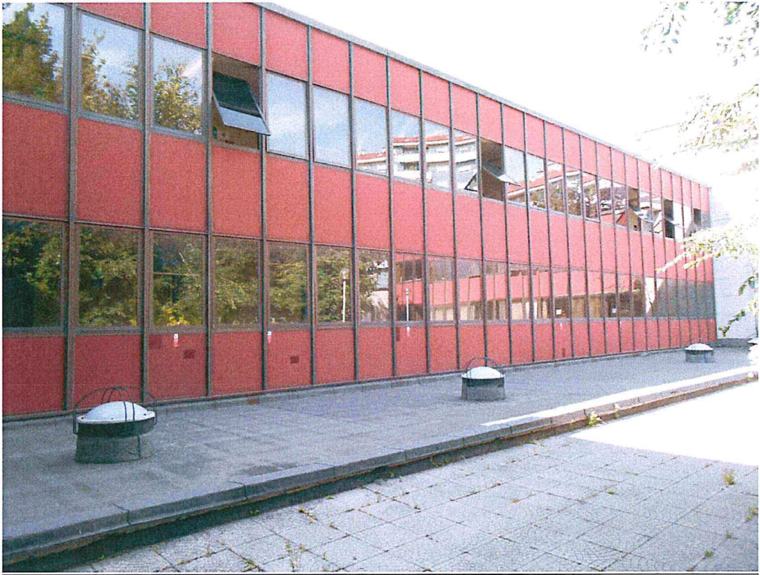
2-FACCIATA esposta a nord
