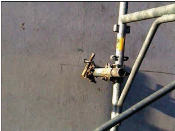
Ancoraggio con barra munita di gancio
