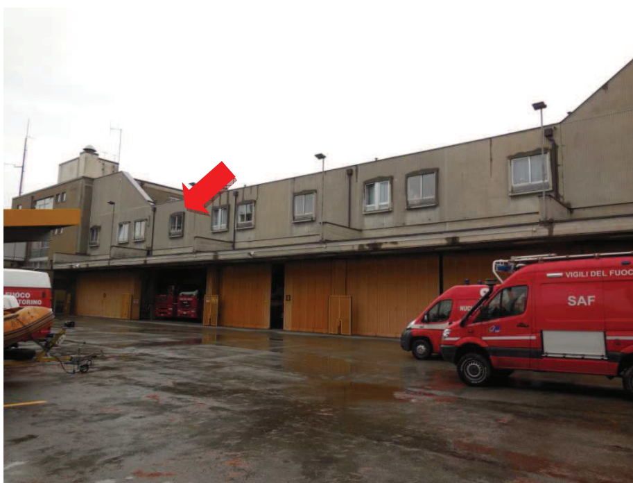
Foto 12-13 – Fabbricato B – Alcuni serramenti vetrati su cui effettuare la manutenzione
