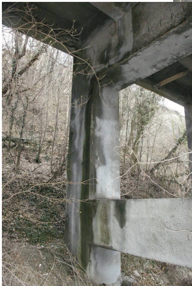
1ª pila, pilastro a monte
