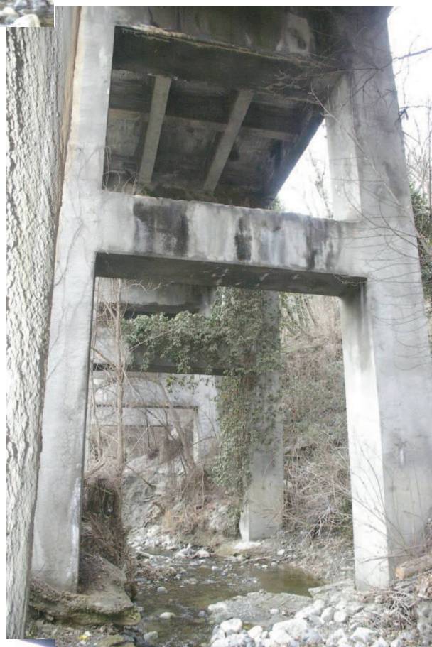
5ª pila lato sinistro
