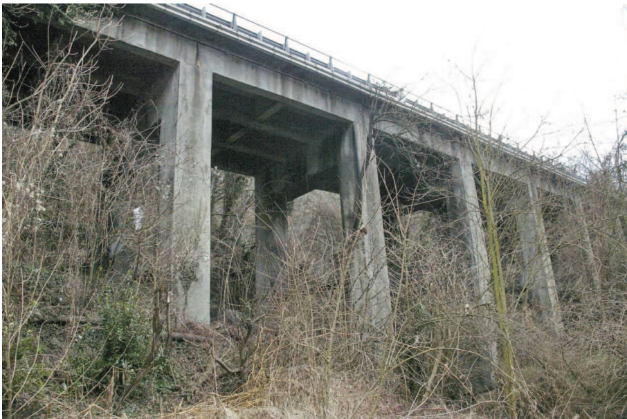
vista viadotto da valle in destra
