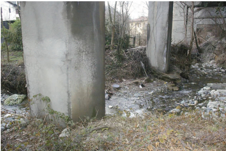
pilastrini a valle 6 a e 5 a pila
