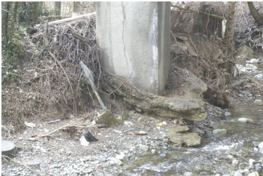
fondazione pilastro a valle 5ª pila
