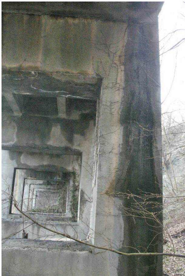
7 a pila, pilastro a monte
