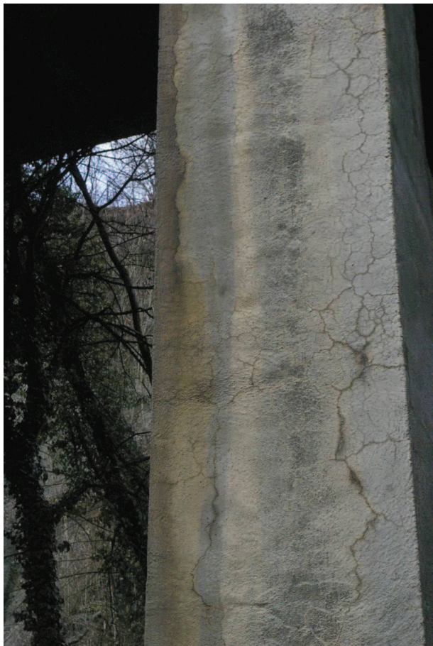
5ª pila, pilastro a valle
