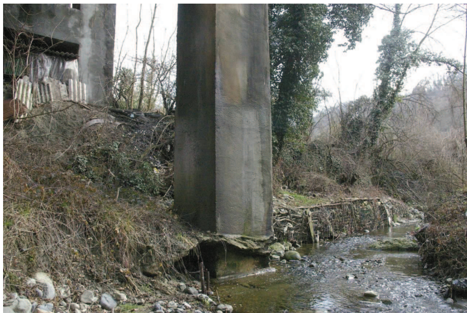
5ª pila, pilastro a valle
