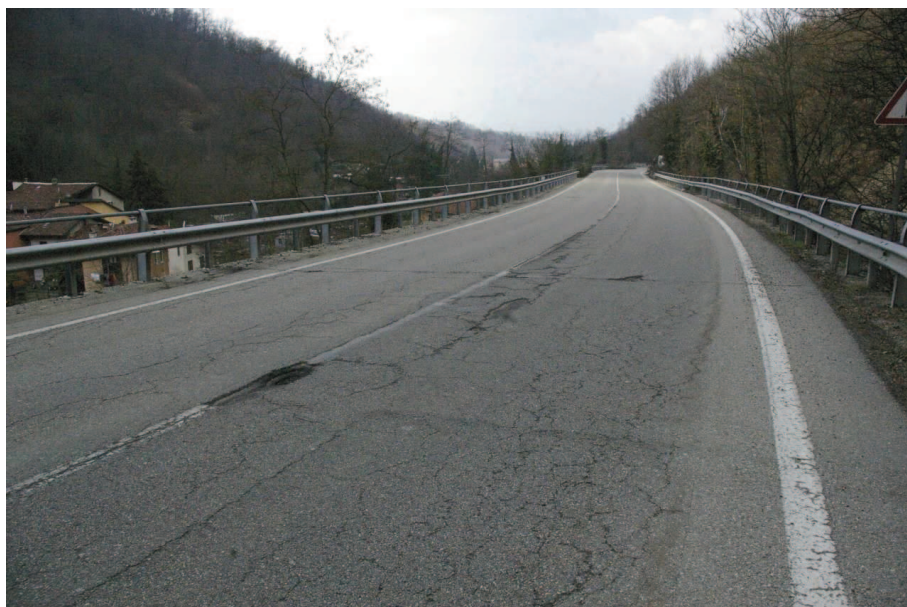
impalcato viadotto visto da I. Pino
