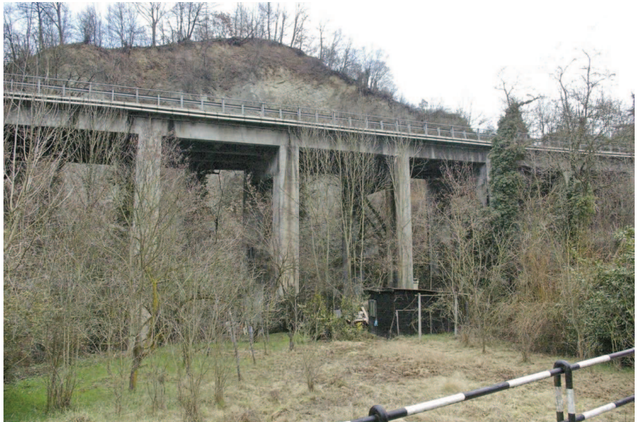
vista viadotto da valle
