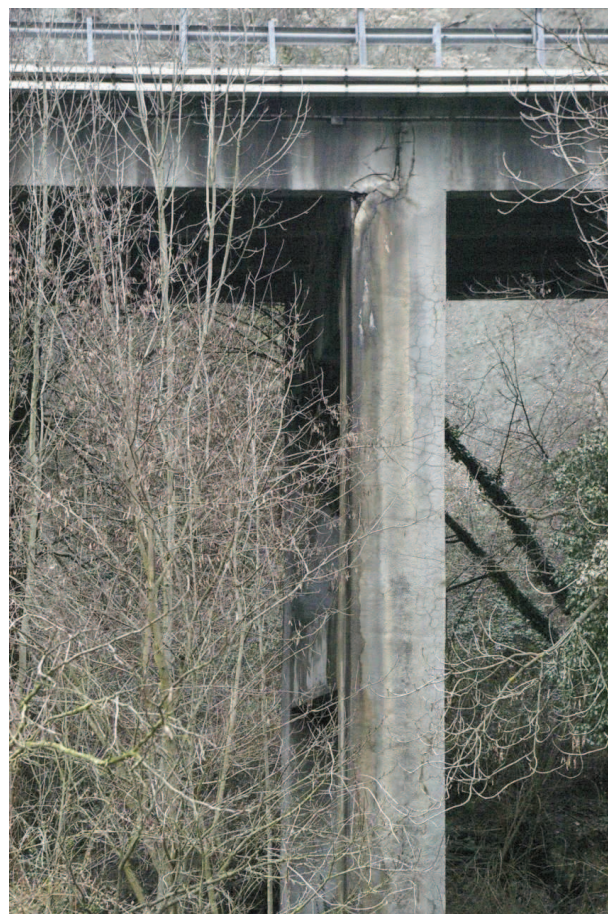
5ª pila, pilastro a valle
