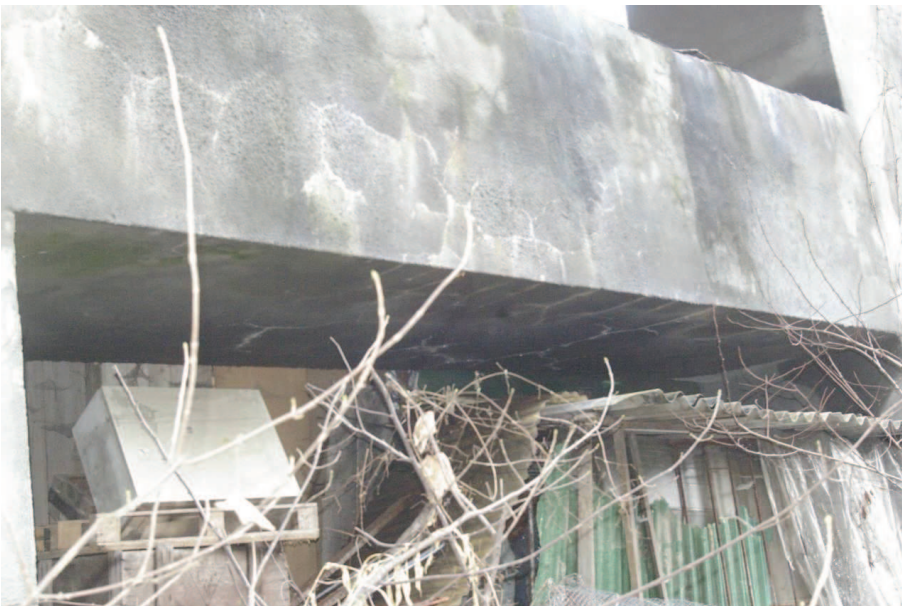
trave inferiore di collegamento pilastri 6 a pila
