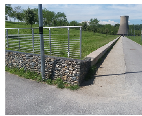
Gabbionate/manufatti in cls prefabbricati
