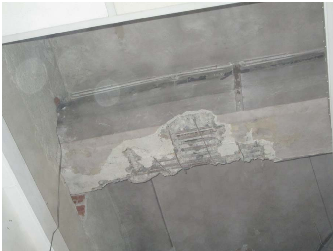
Foto n.1: Vista della trave oggetto di saggio n.1
