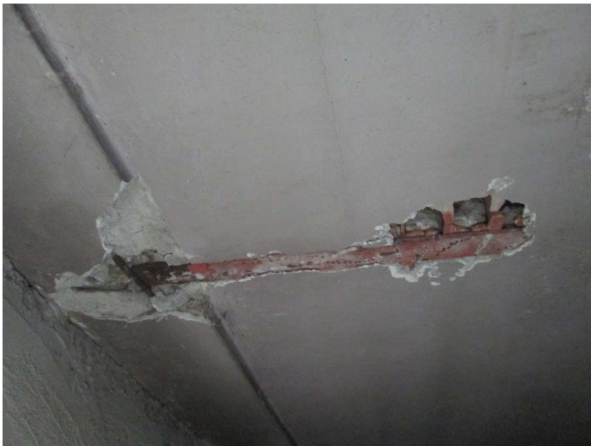
Foto n.5: Vista del solaio oggetto di saggio n.3
