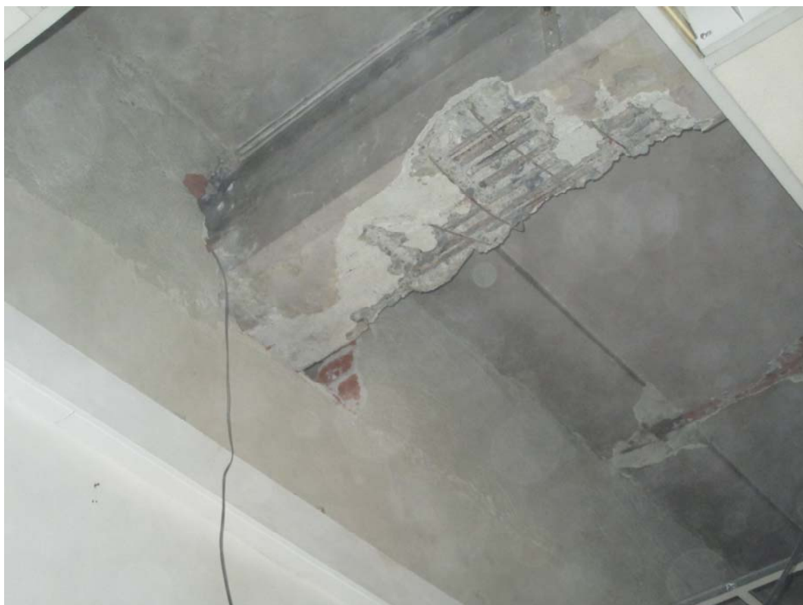
Foto n.2: Particolare del saggio sulla trave ST1
