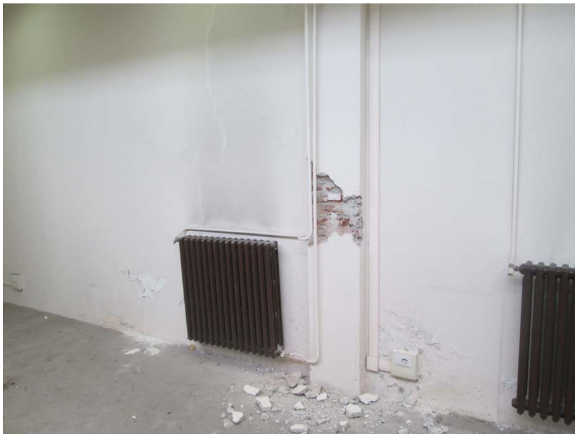
Foto n.15: Vista della trave oggetto di saggio n.8
