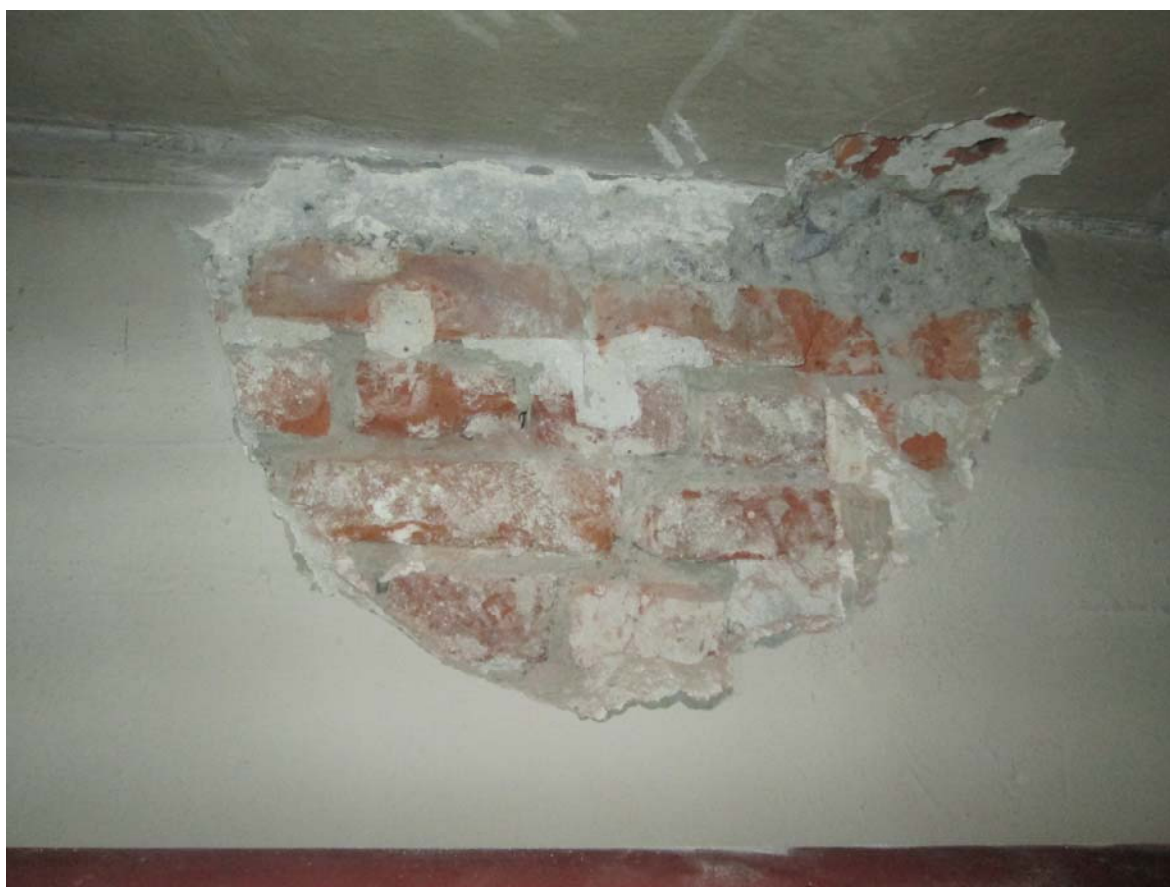
Foto n.14: Particolare del saggio n.7 sulla muratura
