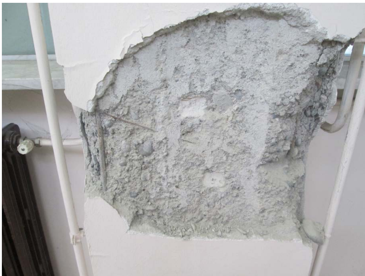
Foto n.20: Particolare del saggio n.10 sul pilastro
