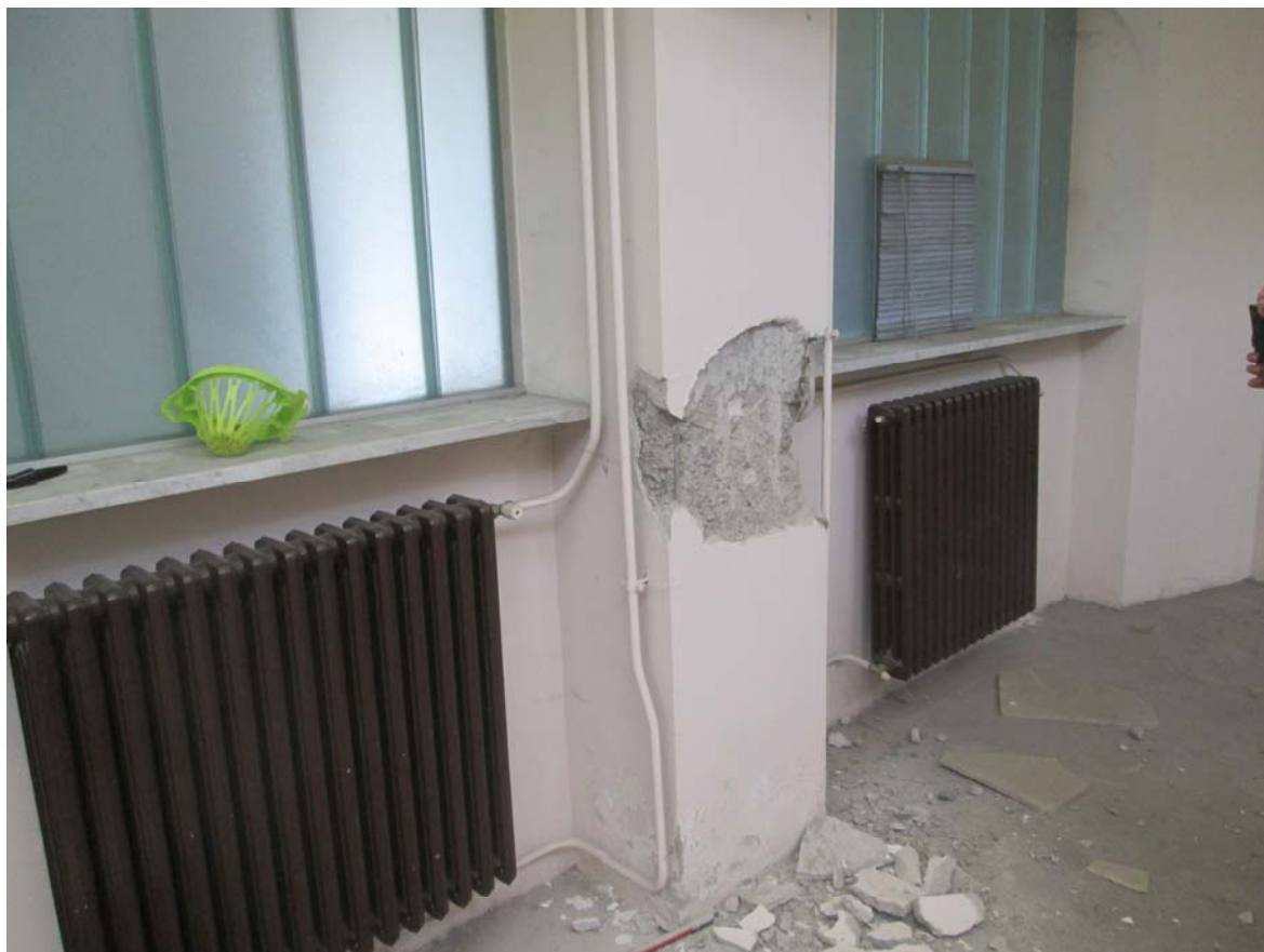
Foto n.19: Vista del pilastro oggetto di saggio n.10
