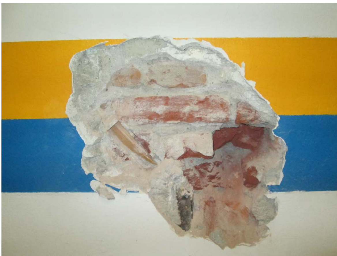
Foto n.12: Particolare del saggio n.6 sulla muratura
