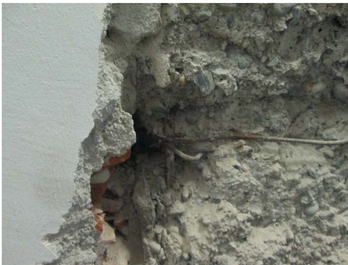
Foto n.18: Particolare del saggio n.9 sul pilastro
