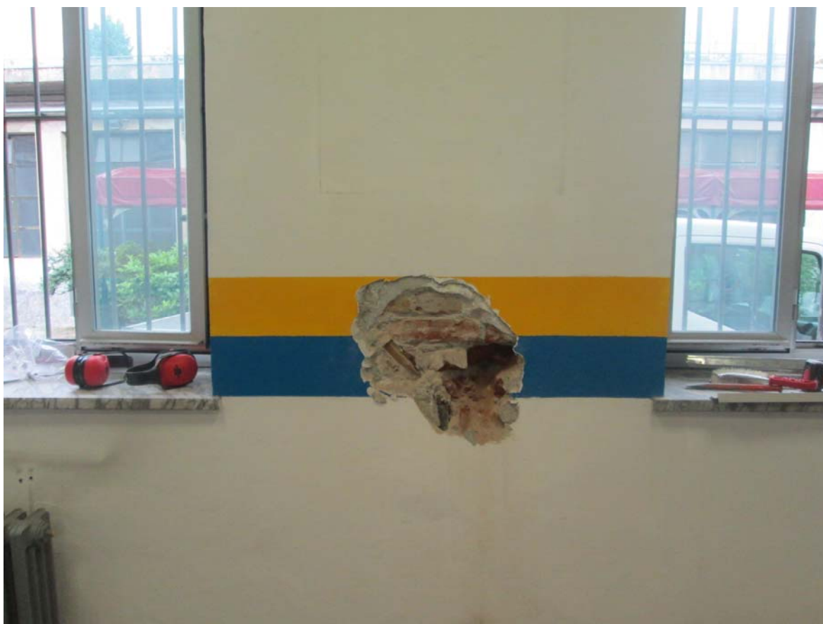
Foto n.11: Vista della muratura oggetto di saggio n.6
