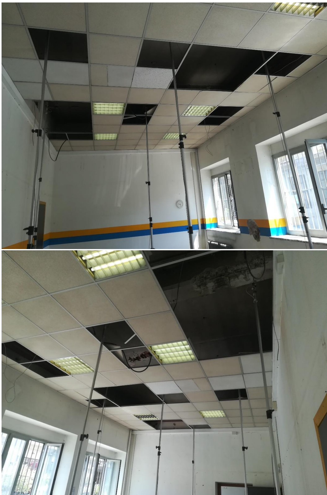
Posizione trasduttori potenziometrici per il rilievo delle deformazioni
