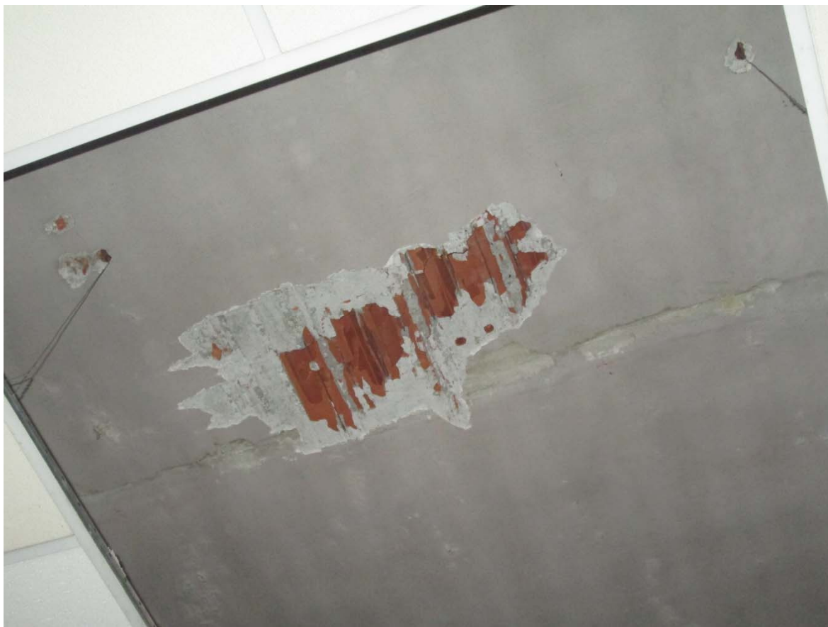
Foto n.7: Vista del solaio oggetto di saggio n.4
