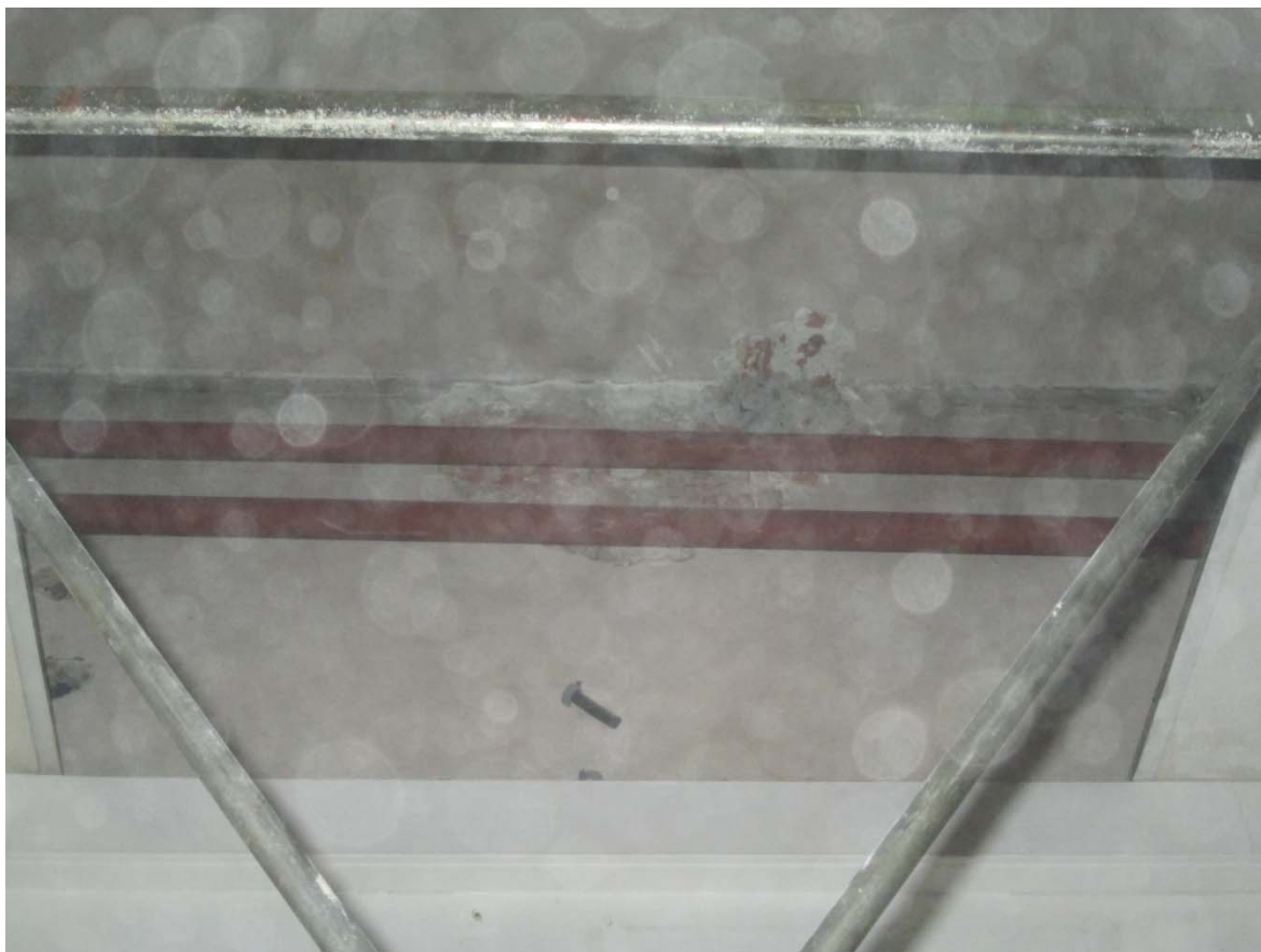
Foto n.13: Vista solaio/muratura oggetto di saggio n.7
