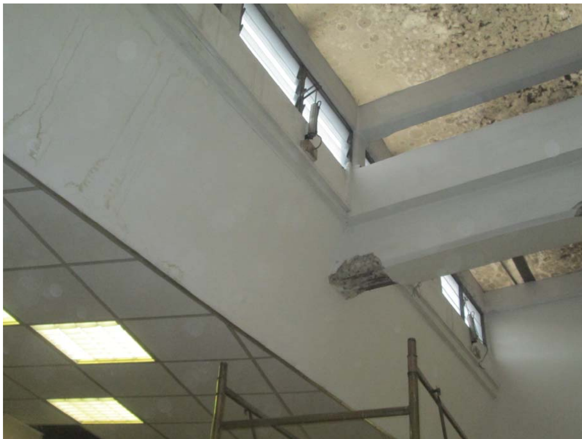
Foto n.3: Vista della trave oggetto di saggio n.2
