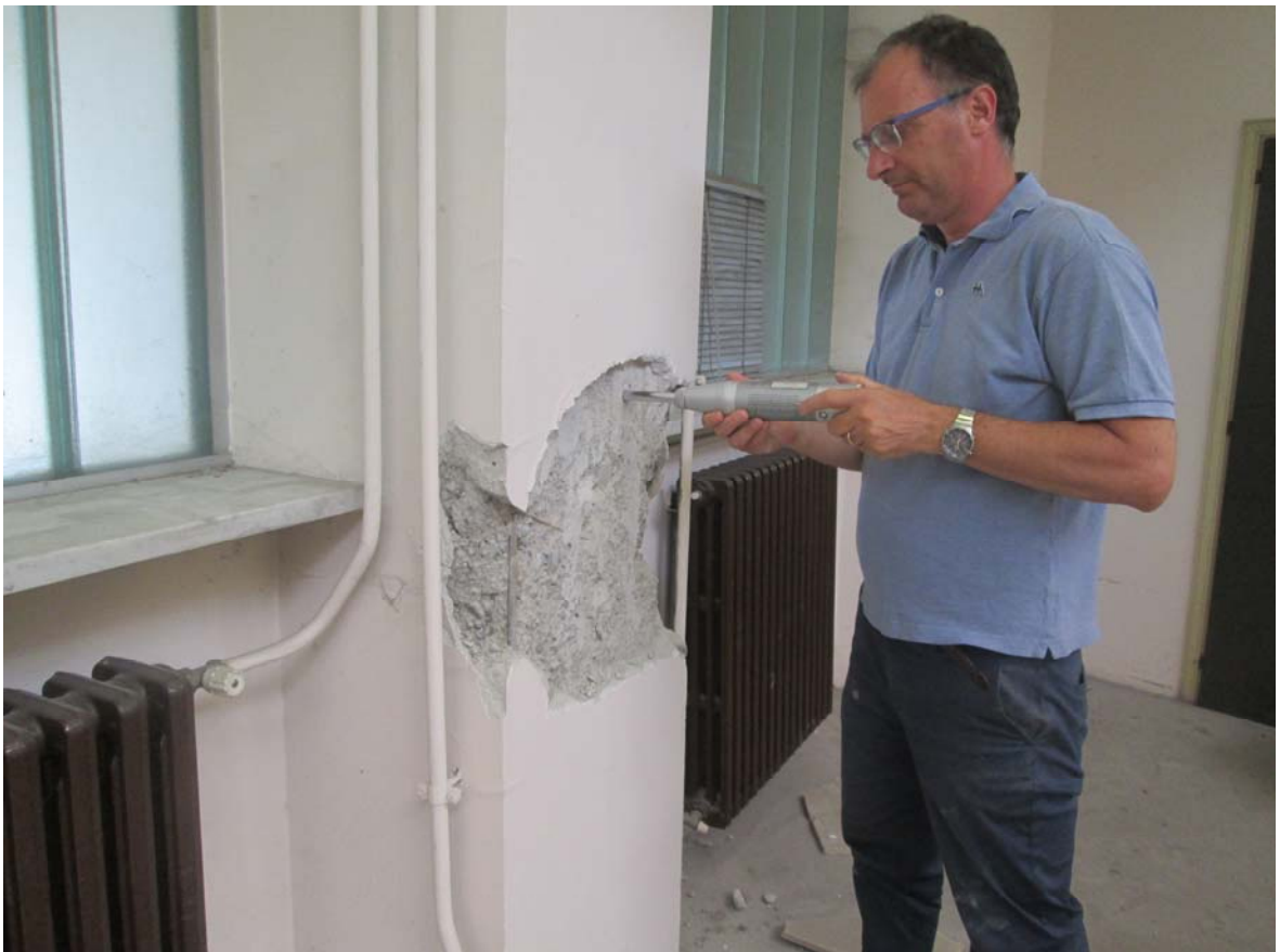
Foto n.26: prova sclerometrica n.4
