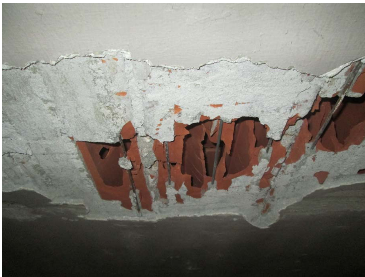
Foto n.8: Particolare del saggio n.4 sul solaio
