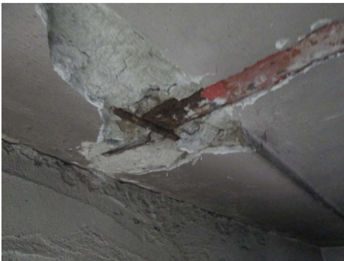
Foto n.6: Particolare del saggio n.3 sul solaio
