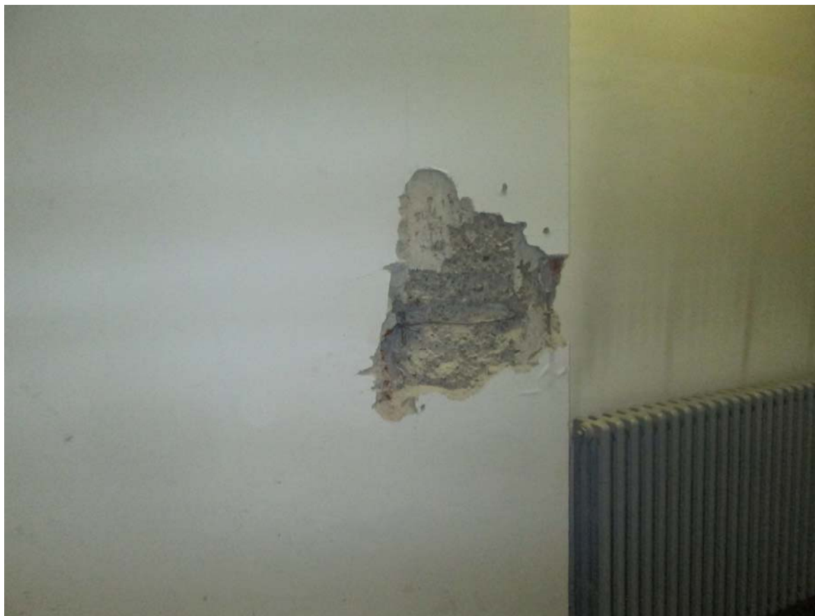
Foto n.17: Vista del pilastro oggetto di saggio n.9
