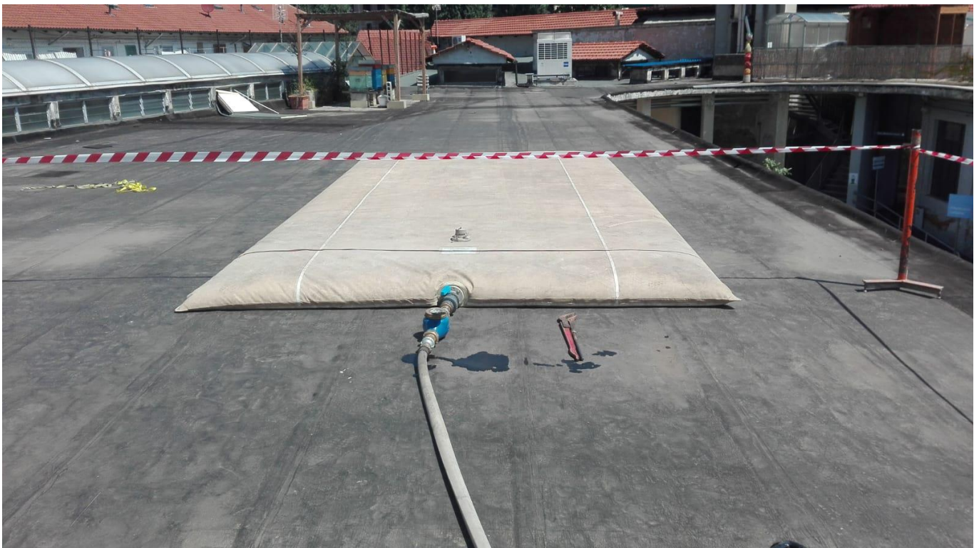
Posizionamento serbatoi di carico-
