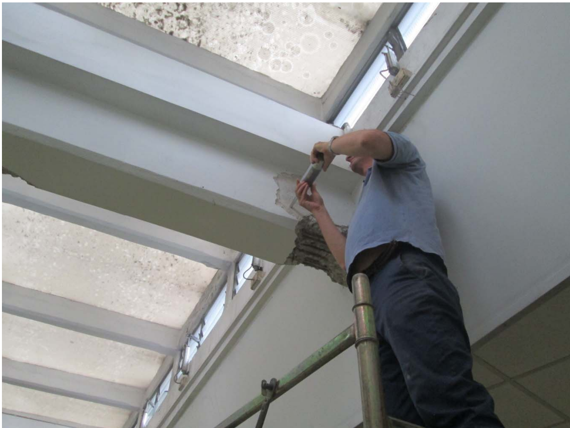
Foto n.25: prova sclerometrica n.3
