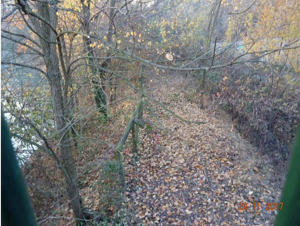
Figura 4-4 – Vista dal camminamento del ponte canale della parte di rilevato dove verrà eseguito il rilevato arginale in progetto. (foto: 2379-DSC01233)
