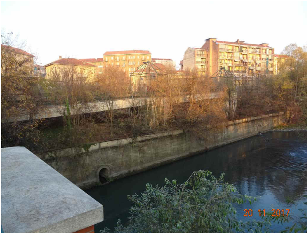
Figura 4-6 – Vista del tratto del Fiume Dora Riparia a valle del ponte canale. (foto: 2379-DSC01242)
