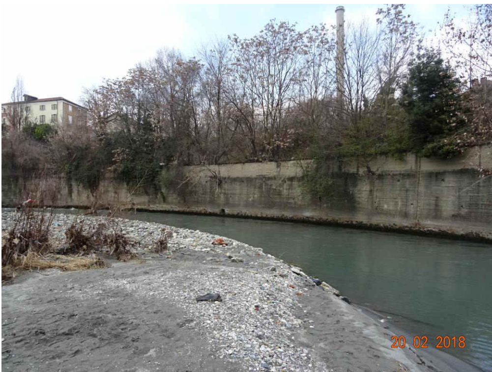
Figura 4-3 – Fiume Dora Riparia a monte del ponte canale visto verso monte dall'alveo. (foto: 2410-DSC01517)
