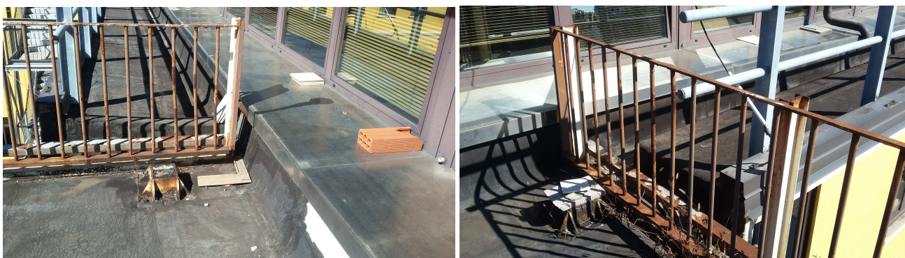
Particolari di aggancio della soletta del terrazzo a sbalzo
