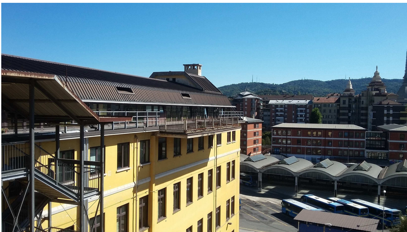
Terrazzo a sbalzo del 5° piano fuori terra
