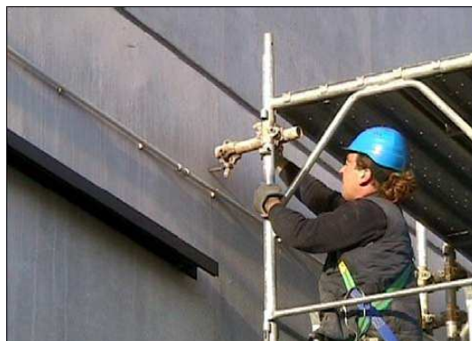
Ancoraggio con barra munita di gancio
