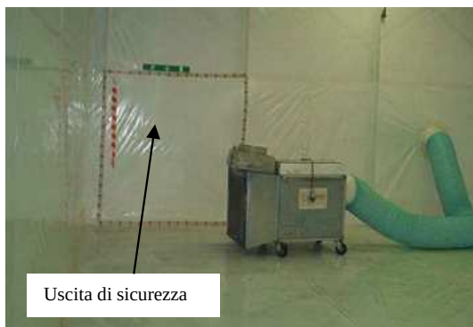
sistema di estrazione dell'aria
