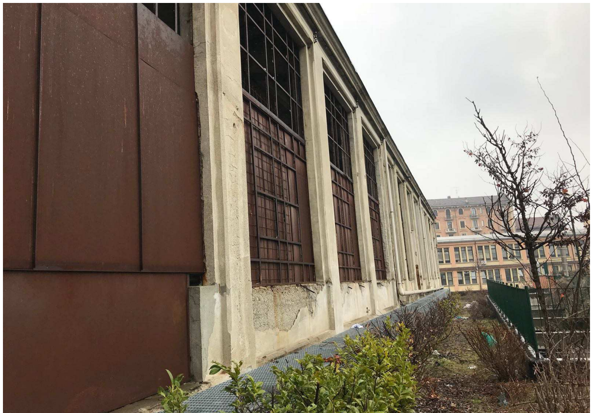
FACCIATA SUD SU PARK PERTINENZIALE (intervento di manutenzione su tutta la facciata)
