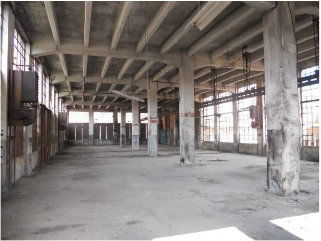
VISTA DEGLI INTERNI – PIANO PRIMO
