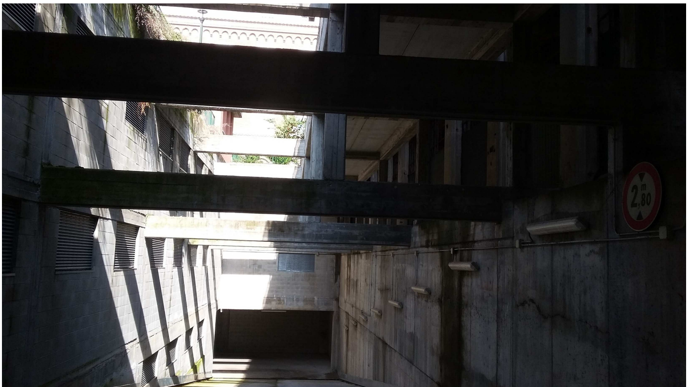
VISTA DELLA RAMPA DI ACCESSO ALL'INTERRATO DEL PARCHEGGIO PERTINENZIALE
