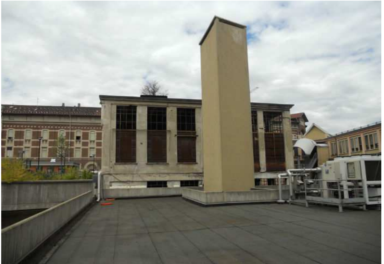
REALIZZAZIONE NUOVO PUNTO DI ACCESSO IN CORRISPONDENZA DELLA PRIMA CAMPATA DEL FABBRICATO, DA CUI PARTE LA PASSERELLA DI COLLEGAMENTO ALLA TERRAZZA SU BOX ESISTENTI
