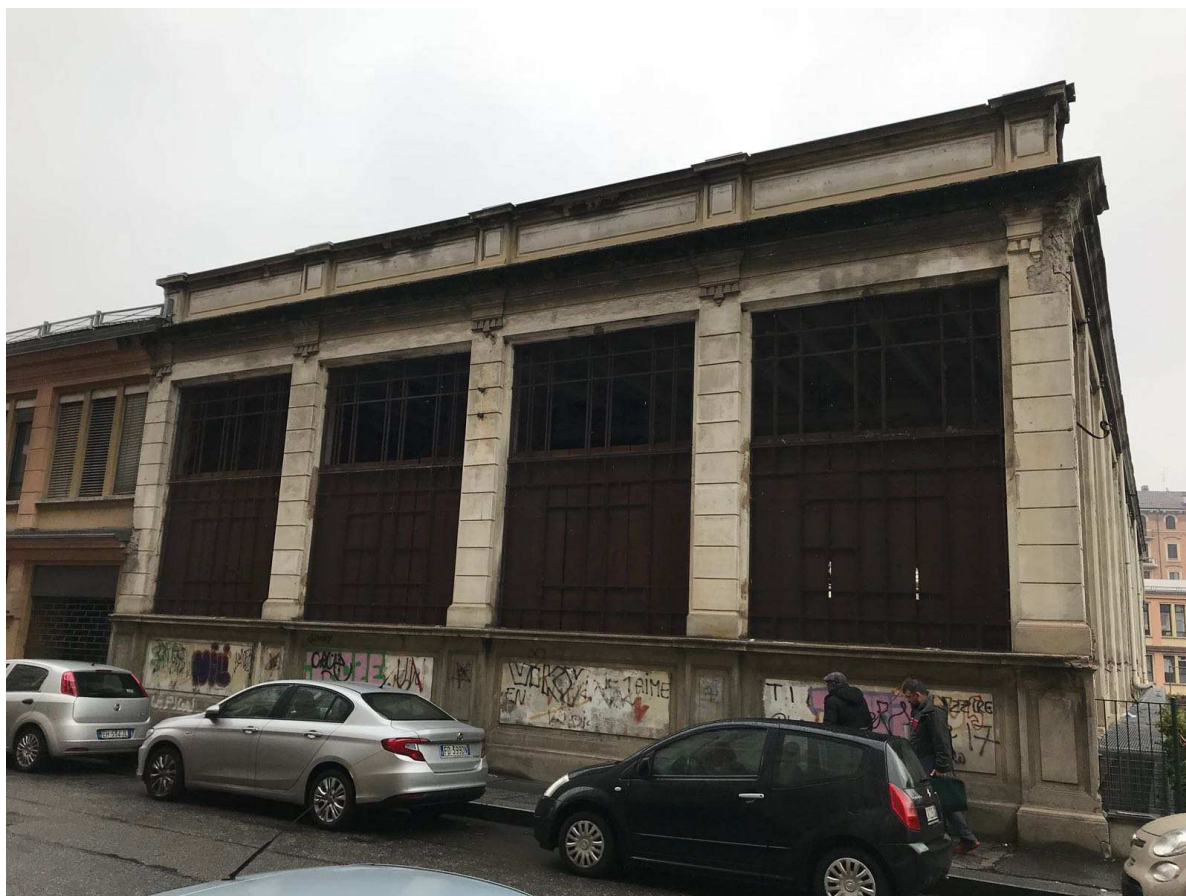
FACCIAE OVEST SU VIA CUMIANA (intervento di manutenzione su tutta la facciata rimozione telai in ferro e realizzazione accesso principale il cui pianerottolo di sbarco è collegato ad una rampa in c.a. per il superamento del dislivello su strada )
