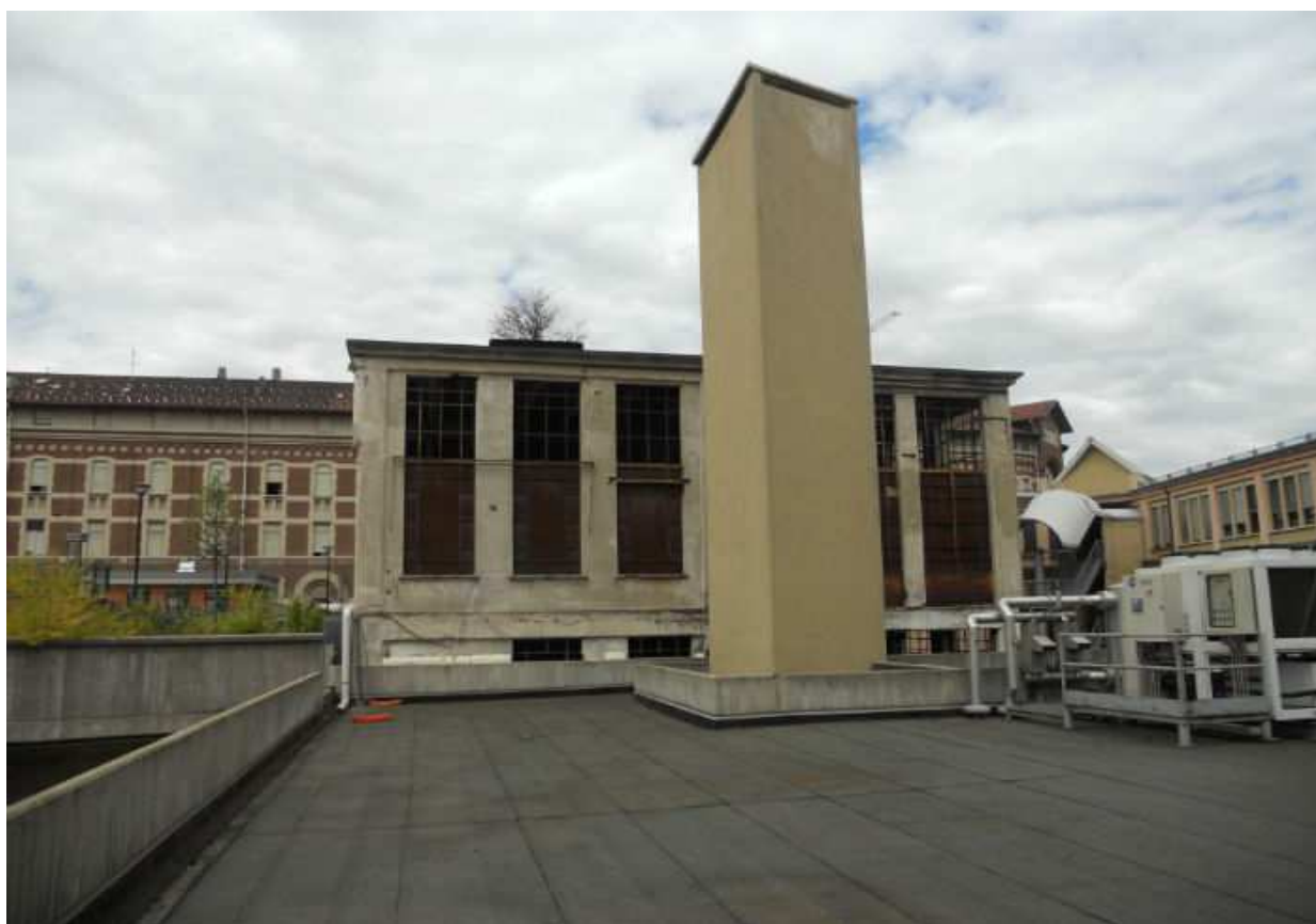
FACCIATA EST – COPERTURA DELLA CENTRALE TERMICA (intervento di manutenzione su tutta la facciata e realizzazione pianerottolo in c.a. di accesso al fabbricato)
