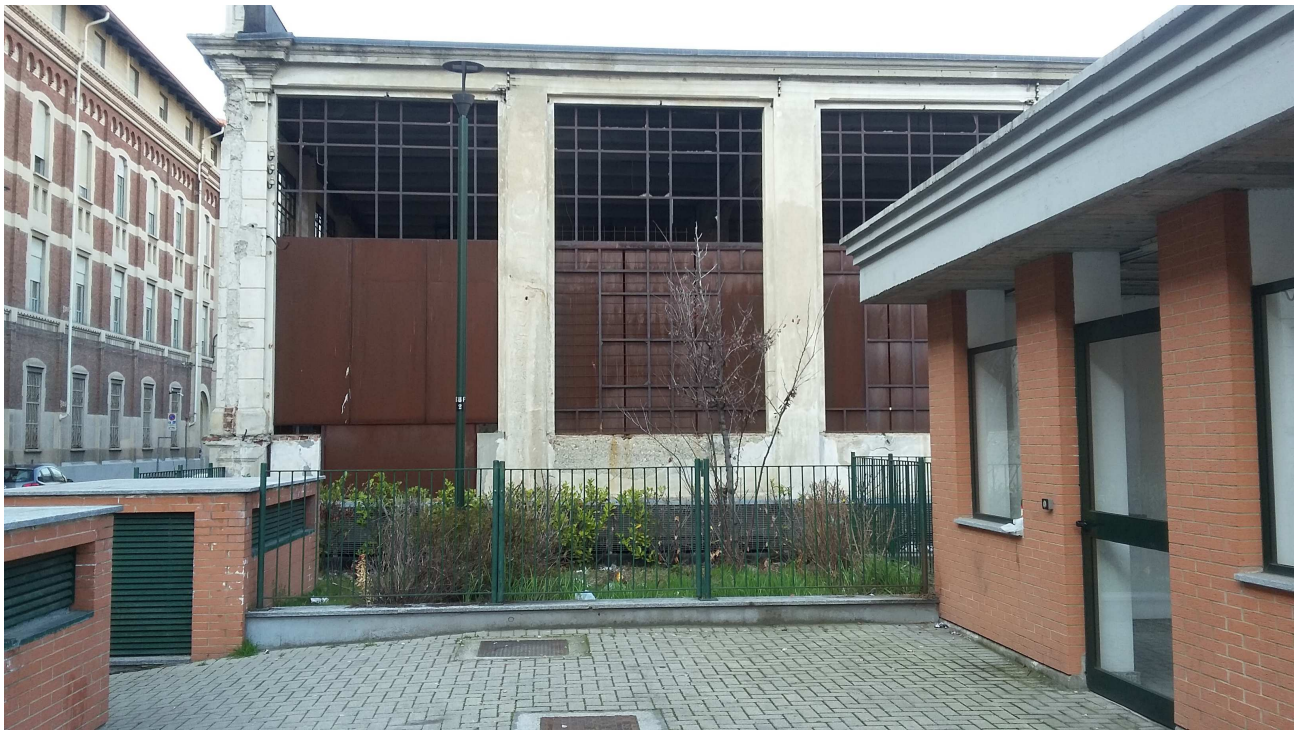
FACCIATA SUD VERSO IL PARK PERTINENZIALE
