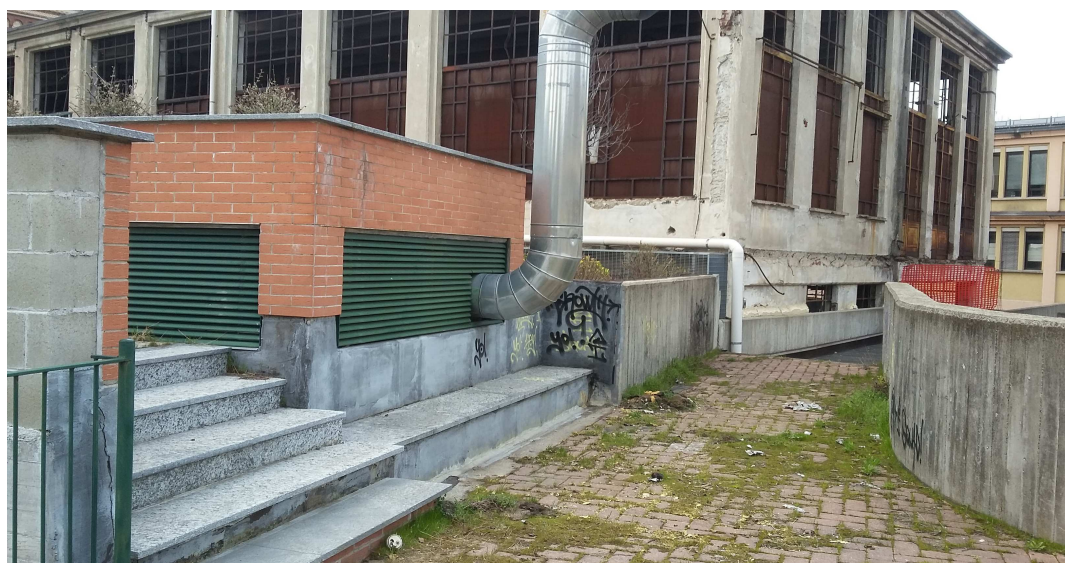
FACCIATA EST VERSO LA CENTRALE TERMICA (intervento di manutenzione su tutta la facciata)
